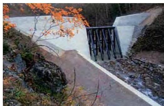
綱製スリット砂防堰堤
