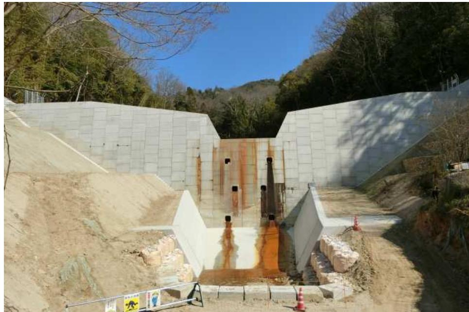
奥之谷川の砂防堰堤は、平成26年度に工事着手し整備を進めてきました。平成30年7月豪雨によって土砂災害が発生しましたが、整備途中の堰堤が効果を発揮し土砂の一部を受け止めることができました。その後残りの工事に着手し、11月初旬に本堤工、3月末に側壁工等の工事が完成しました。引き続き事業全体の早期完成に向けて、取り組んでまいります。
