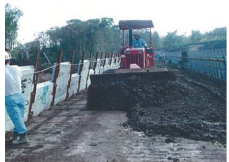
写真-2 砂防ソイルセメント（INSEM）工法の施工状況 1)
