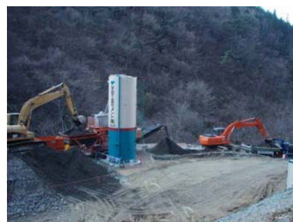
写真-4 自走式攪拌機による INSEM 材の確保
