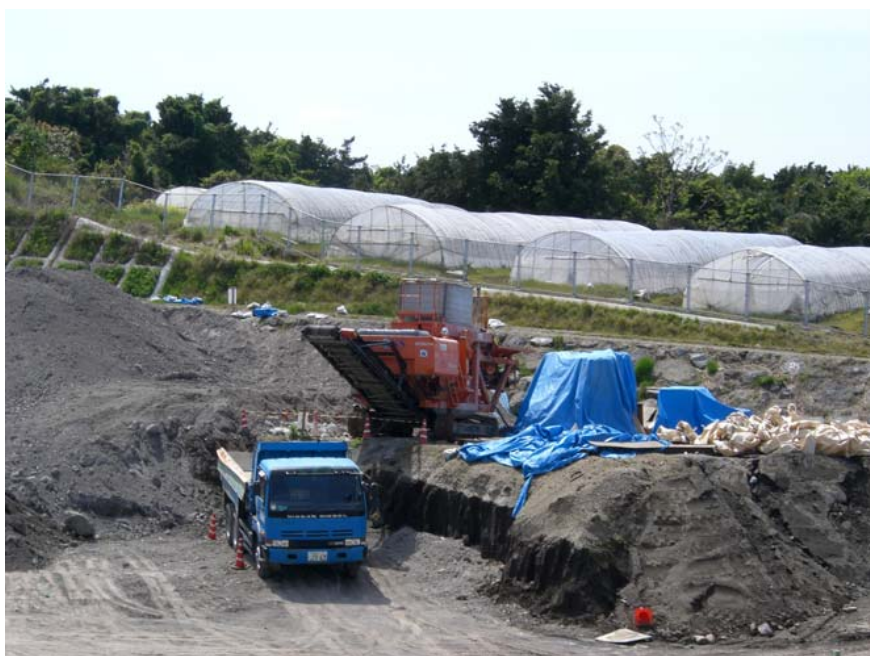
写真-2 自走式土質改良機（加水機能付）
