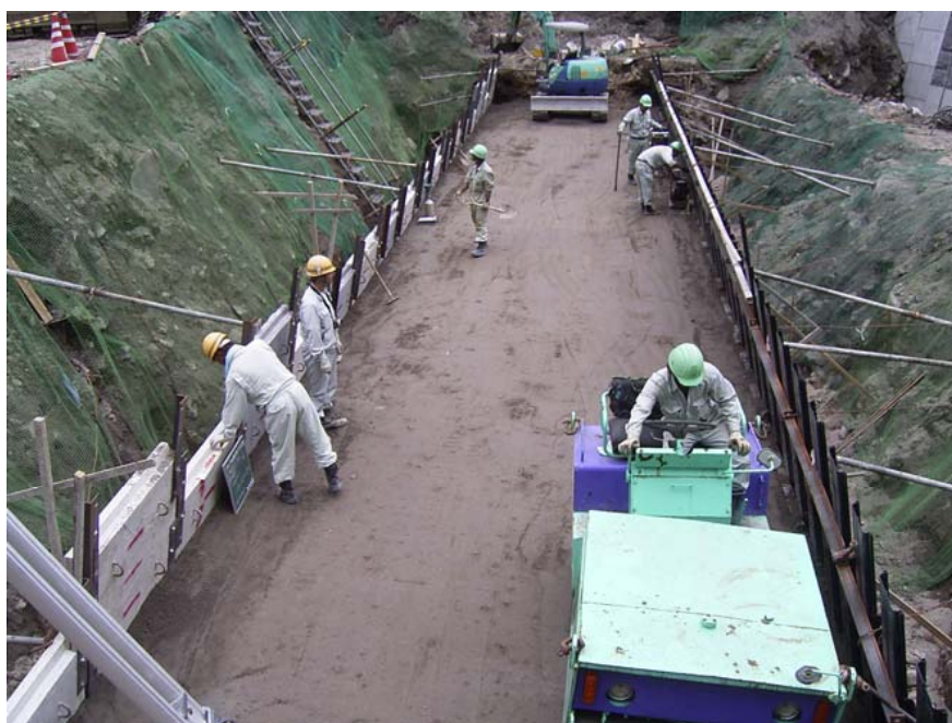
写真-4 転圧状況 (端部の施工はタンパによる人力施工)
