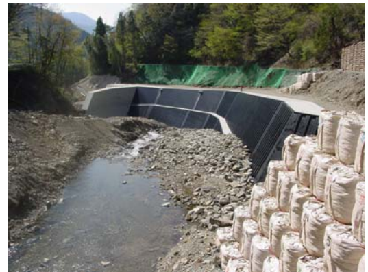
写真-6 完成した導流工
