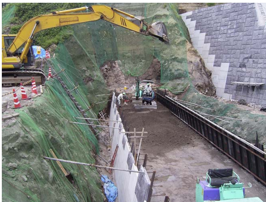
写真-3 ソイルセメント投入状況 (敷均し厚さ 25cm)
