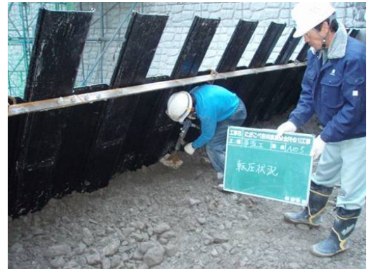
写真-5 人力による端部施工の状況
