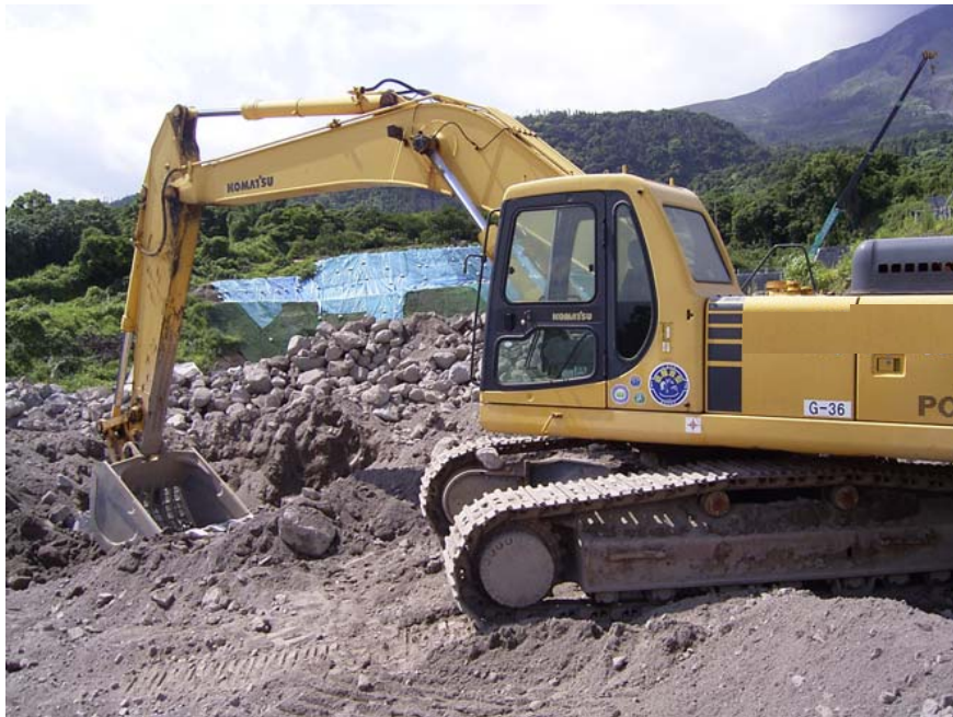
写真-1 スケルトンバケットを用いた現地発生材のふり分け
