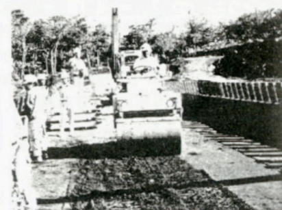
内部材転圧状況
