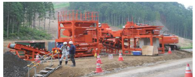
SBウォール工法の機械化施工(INSEM専用製造プラント)
