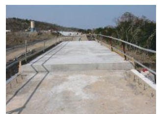
天端保護コンクリート打設
