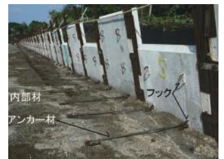
アンカー材設置
