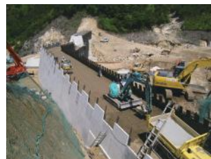
INSEM材の締固め
