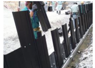
外部保護材組立（上流部）
