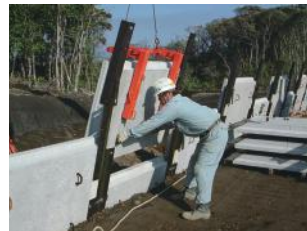
外部保護材組立（下流部）
