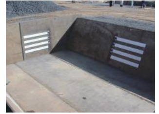
混合施設設置
