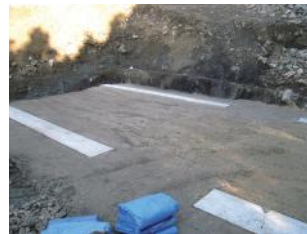
基礎均しコンクリート打設
