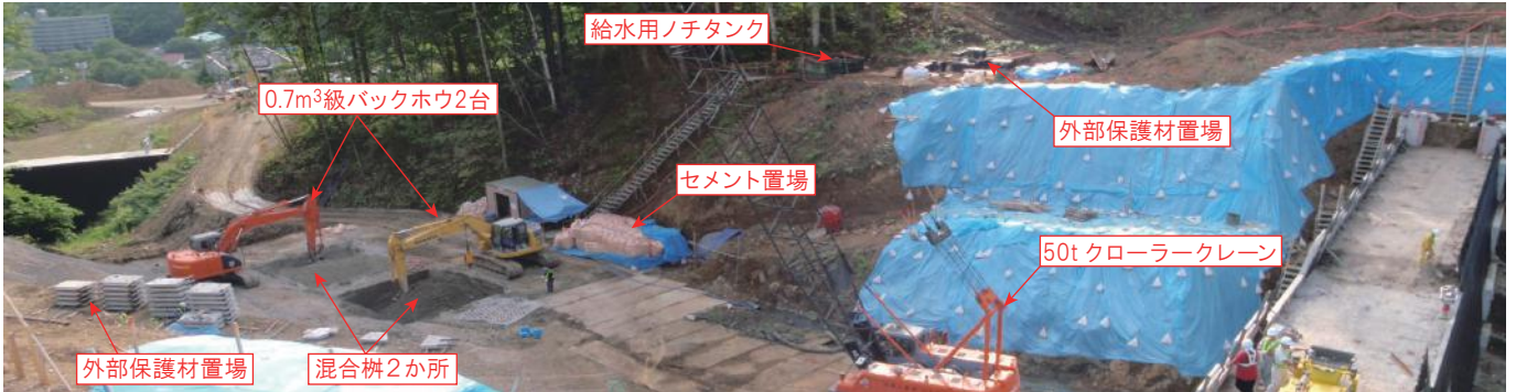
施工ヤード事例(内部材ボリューム 1,835m³、打設日数12日間)
