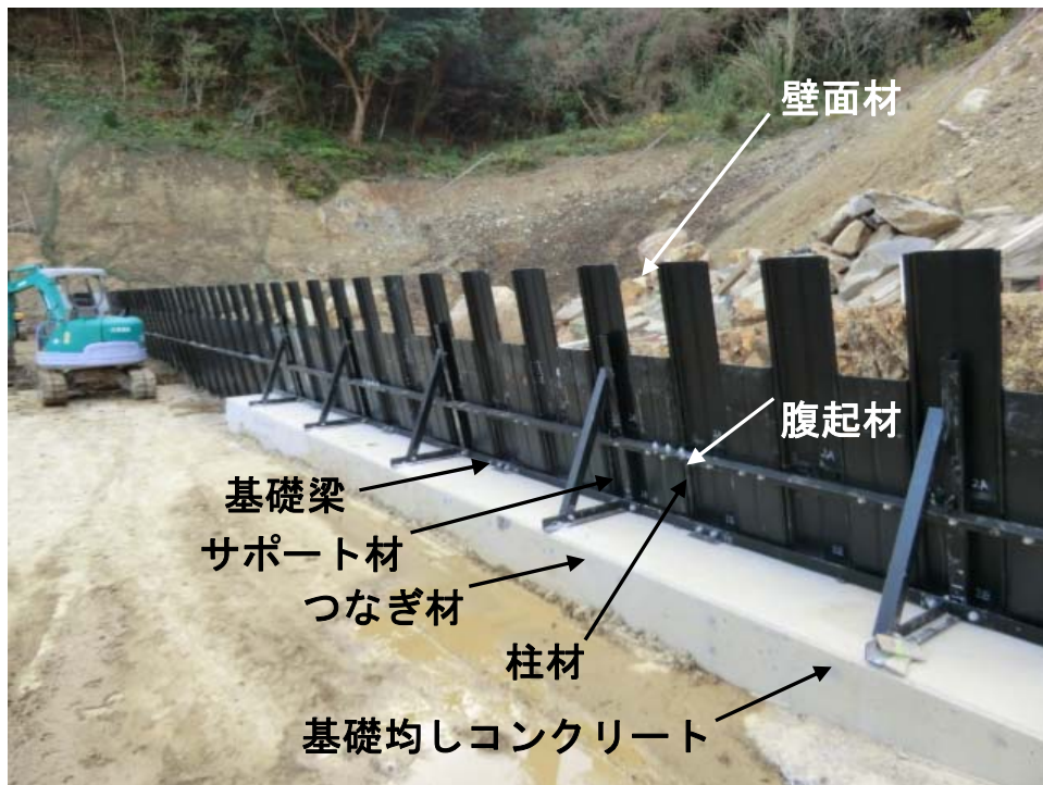
写真- 4.31 基礎部外部保護材の部材名称
