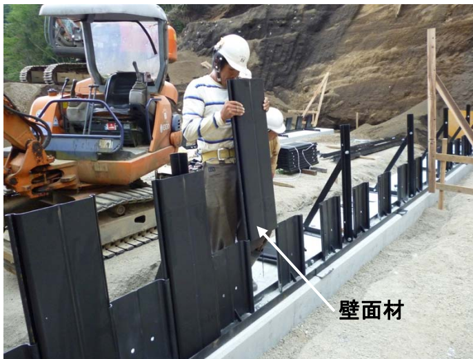
写真- 4.45 壁面材の建て込み
