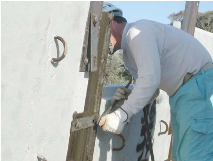
写真- 4.71 外部保護材ののり面勾配調整
