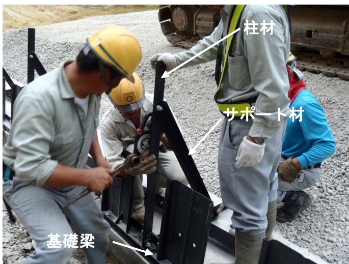
写真- 4.43 柱材・サポート材の組立
