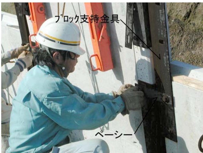
写真- 4.69 ペーシー取付
