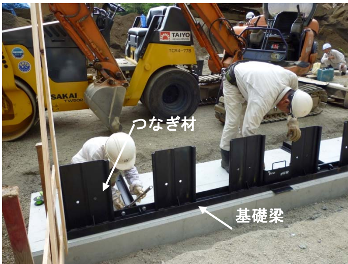
写真- 4.36 つなぎ材の設置
