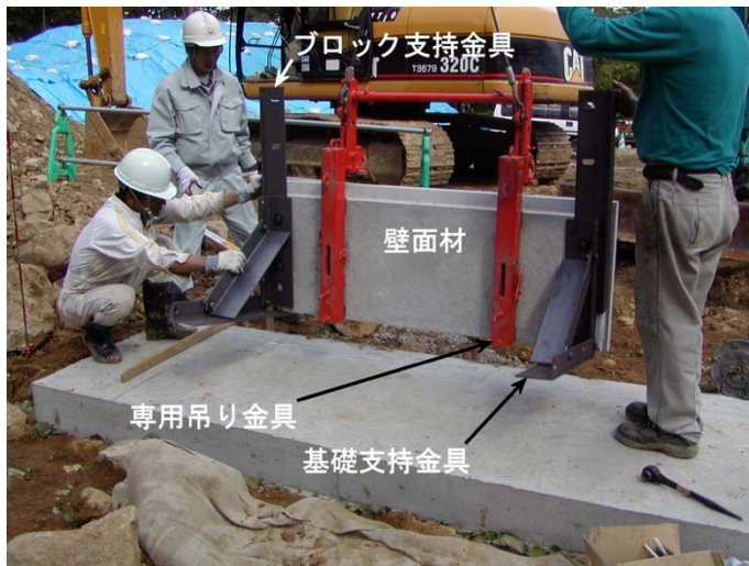
写真- 4.60 1 段目外部保護材の設置
