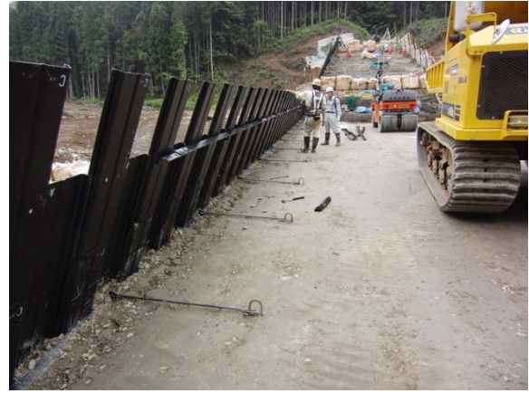
写真- 4.20 左：ランマによる締固め・右：外部保護材近傍の内部材
