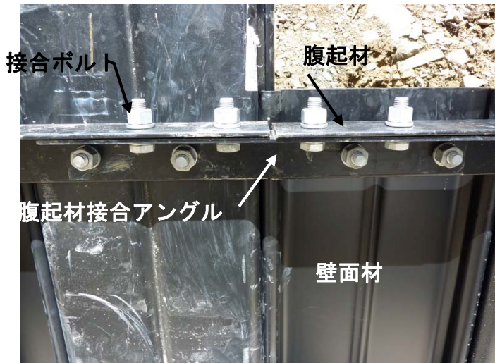
写真- 4.47 腹起材どうしの接合
