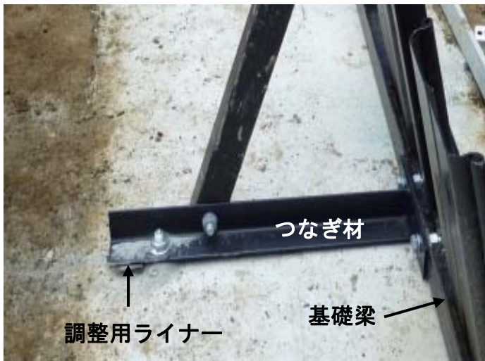
写真- 4.41 つなぎ材の高さ調整
