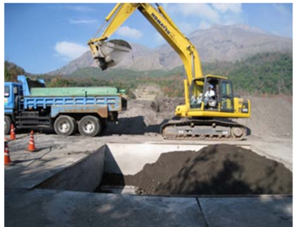
写真- 4.15 内部材の積み込み状況
