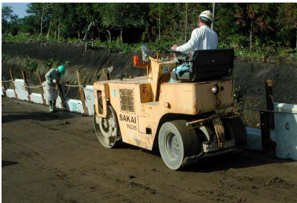
写真-4.19 左：振動ローラによる締固め・右：ハンドガイドローラによる締固め
