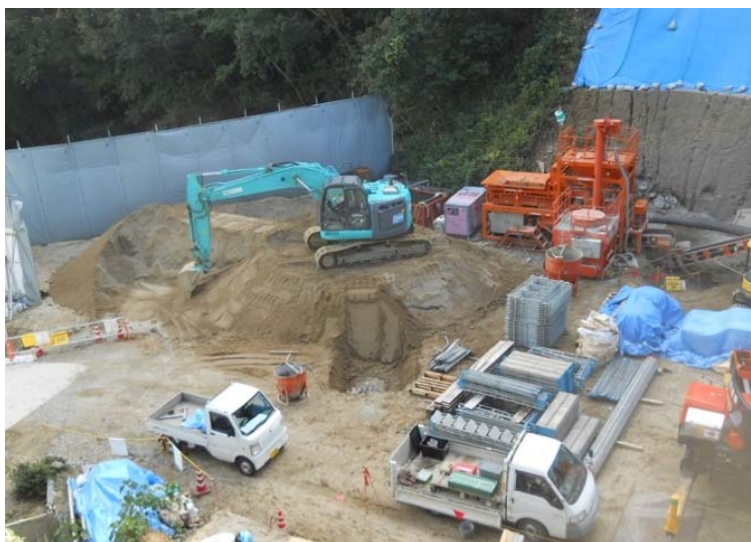
写真-4.4 土砂ストック，混合ヤードの配置例：モデル1事例 (INSEM プラント→内部材製造，ラフテレーンクレーンによる投入)
