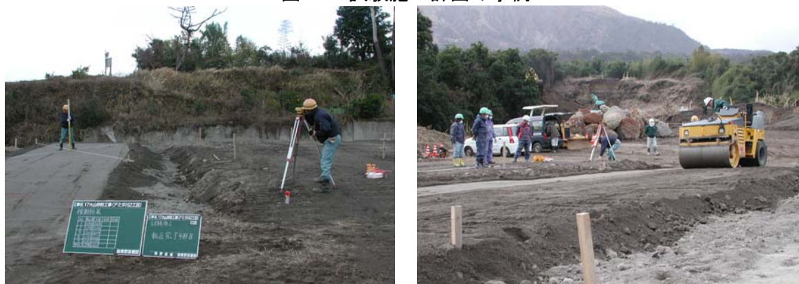
写真- 4.1 試験施工の状況
