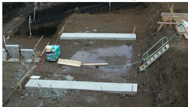
写真-4.30 基礎均しコンクリートの打設例
