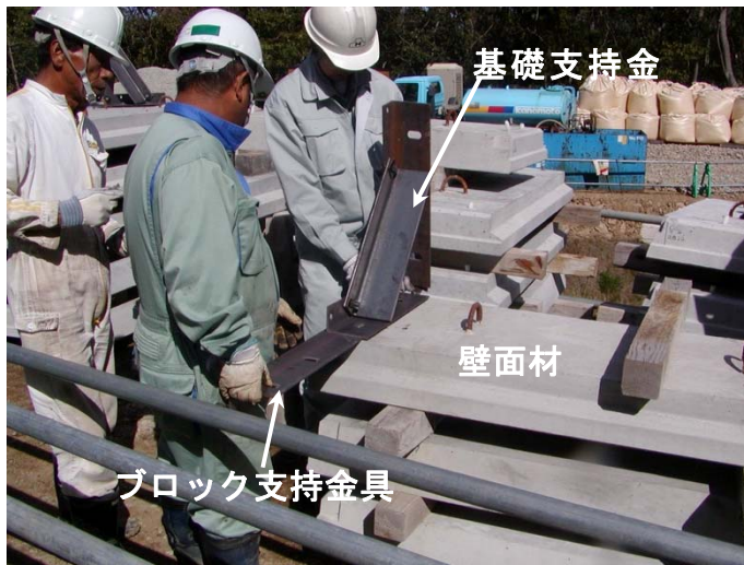
写真- 4.59 基礎支持金具の取付
