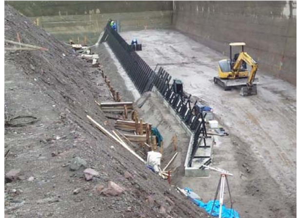
写真- 3.7 間詰 (埋戻し) 設置状況 (左 : 型枠有・右 : 盛れこぼし)
