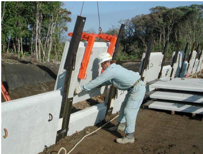
写真- 4.68 外部保護材の設置
