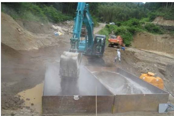
写真- 4.12 混合枓への加水状況
