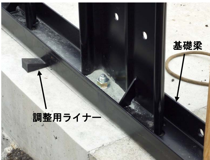
写真- 4.40 基礎梁の高さ調整
