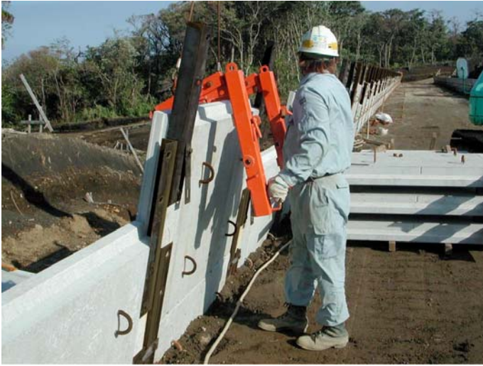
写真- 4.70 専用吊り金具の取り外し
