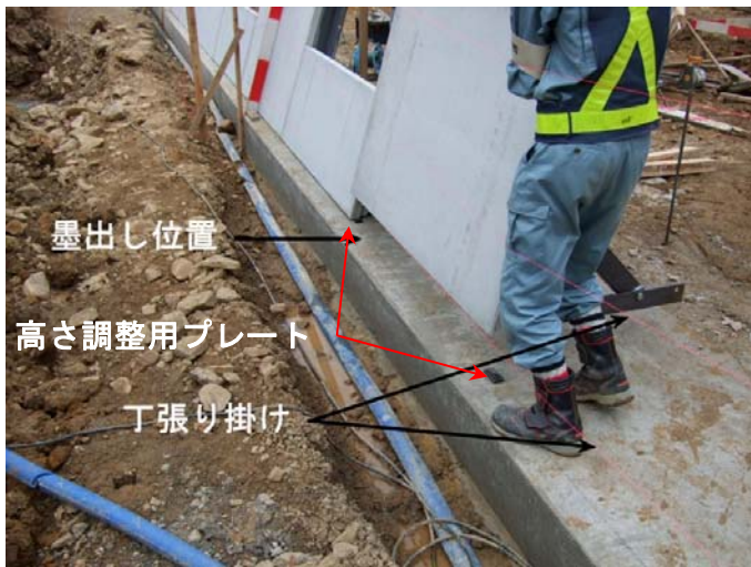
写真- 4.56 基礎部 墨出し・丁張り掛け
