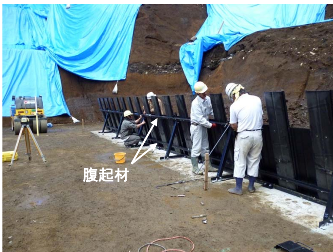
写真- 4.46 腹起材の設置
