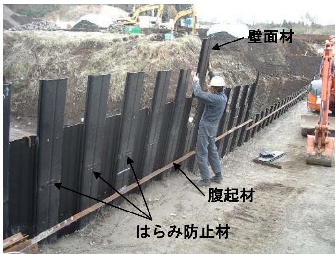
写真- 4.49 壁面材の建て込み
