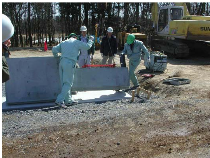
写真- 4.61 1 段目外部保護材の設置
