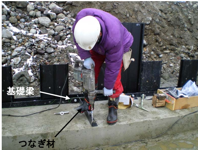
写真- 4.38 あと施工アンカー位置の削孔
