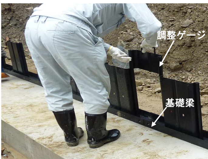
写真- 4.34 基礎梁の設置
