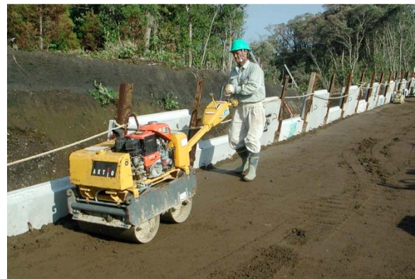
写真-4.19 左：振動ローラによる締固め・右：ハンドガイドローラによる締固め
