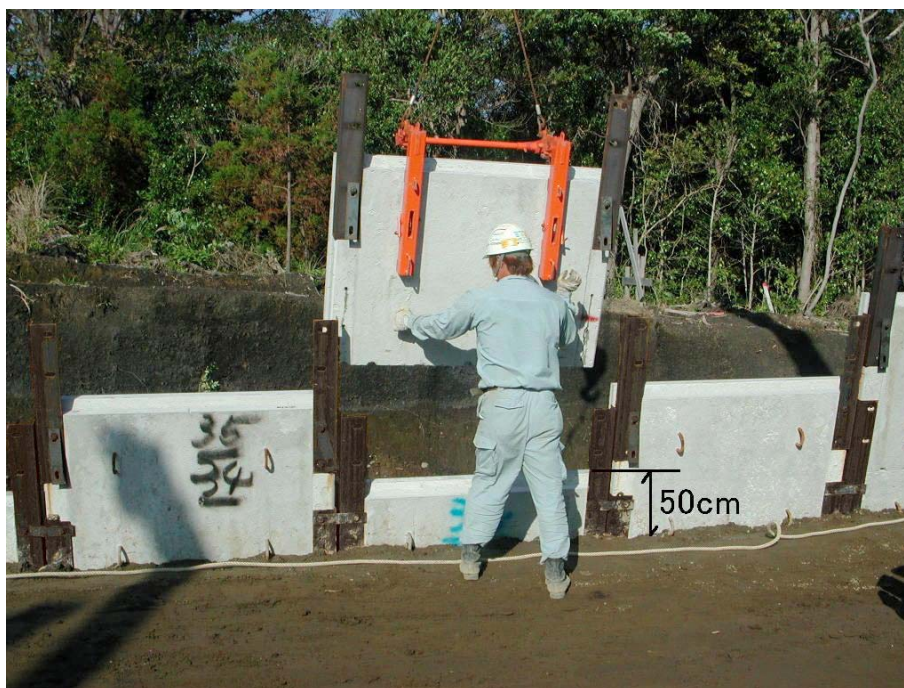
写真-4.28 外部保護材の組立状況
