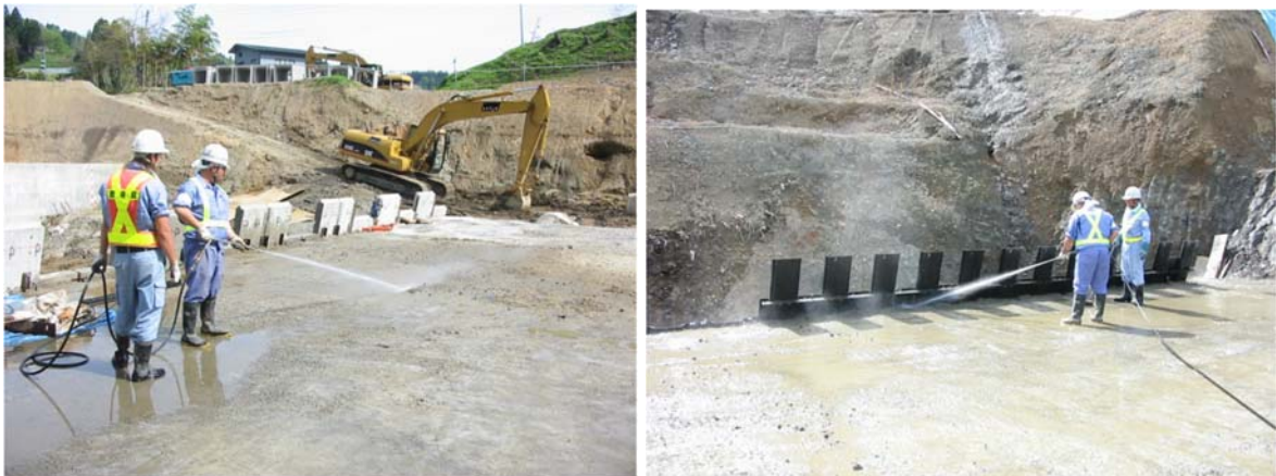
写真- 4.21 右：中央部清掃・水散布状況・左：端部清掃・水散布状況
