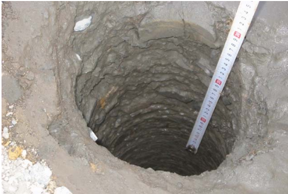
写真- 3.4 コア抜き後内部材状況
