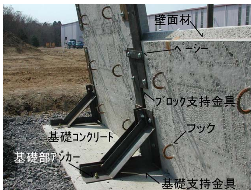
写真- 4.55 基礎部外部保護材の部材名称
