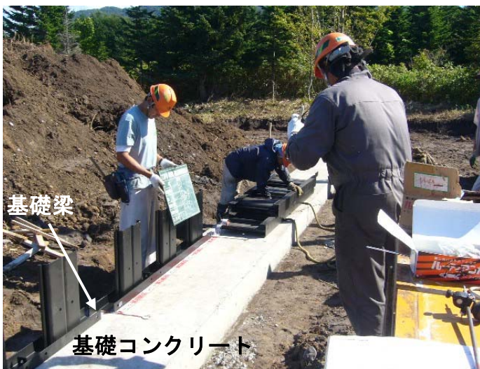
写真- 4.33 基礎梁の設置
