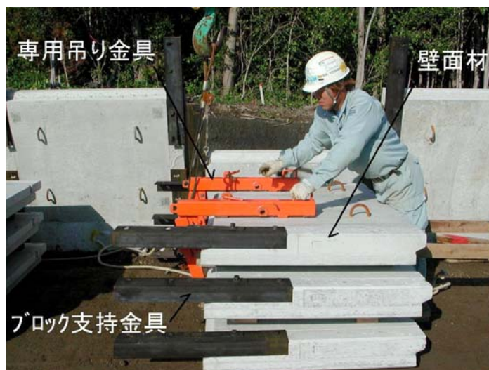
写真- 4.66 専用吊り金具の取付
