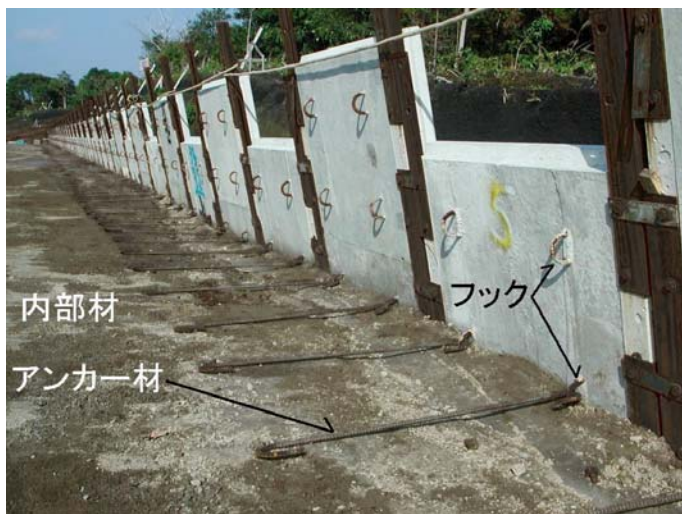
写真- 4.64 アンカー材の設置
