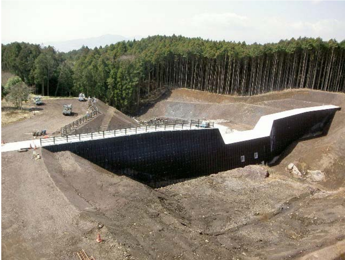
写真- 4.73 上流外部保護材（軽量鋼矢板）
