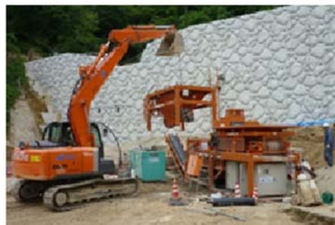
写真-4.7 INSEM プラントの組立状
