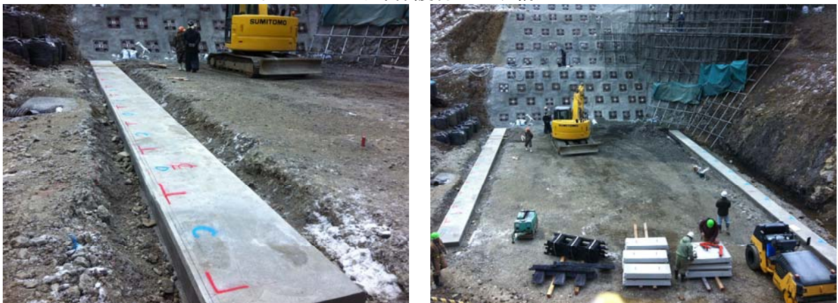
写真- 3.1 基礎均しコンクリート設置状況
