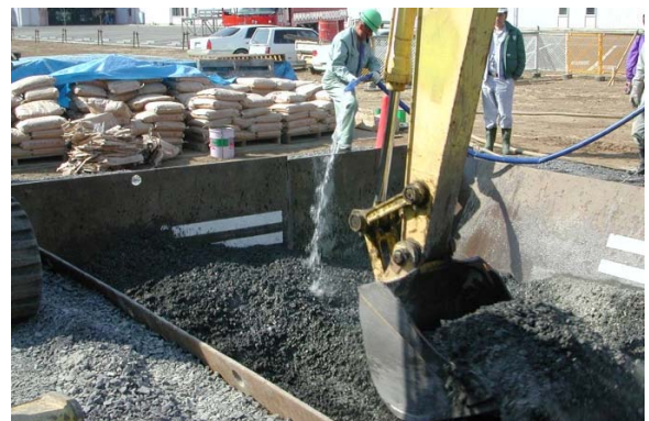
写真- 4.12 混合枓への加水状況
