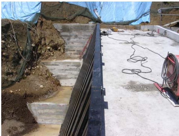
写真- 3.7 間詰 (埋戻し) 設置状況 (左 : 型枠有・右 : 盛れこぼし)
