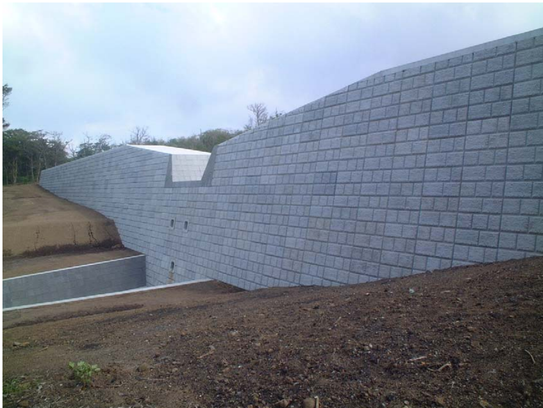
写真- 4.74 下流外部保護材（コンクリートブロック）
