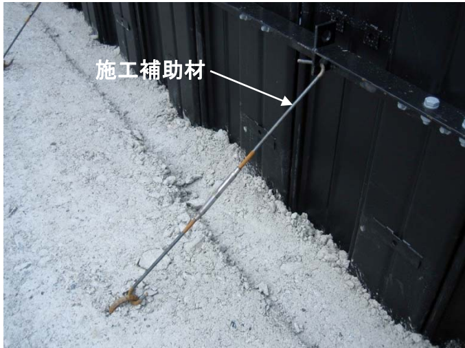
写真- 4.53 施工補助材の設置
