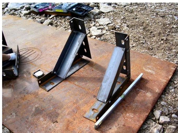
写真- 4.58 基礎支持金具の組立
