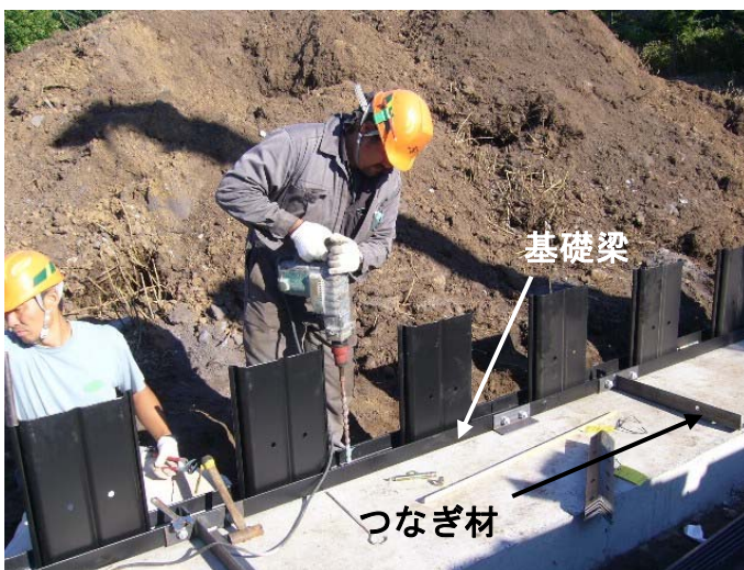
写真- 4.37 あと施工アンカー位置の削孔
