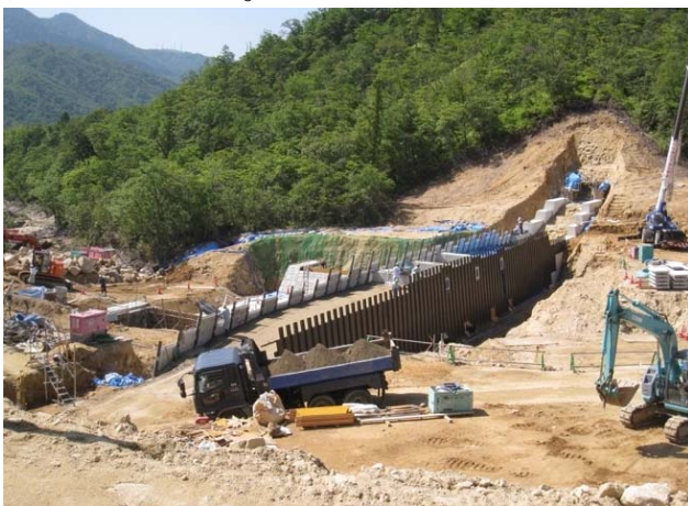
写真- 4.16 内部材の運搬状況（左：ダンプトラック，右：ラフテレーンクレーン）
