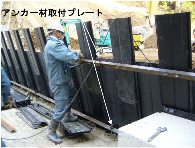
写真- 4.50 腹起材の設置
