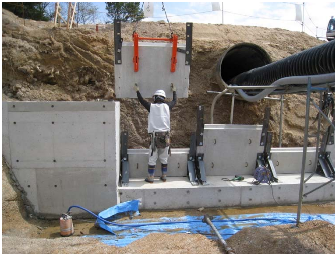
写真- 4.67 外部保護材の設置
