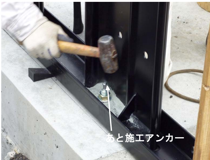
写真- 4.39 あと施工アンカーの打込み
