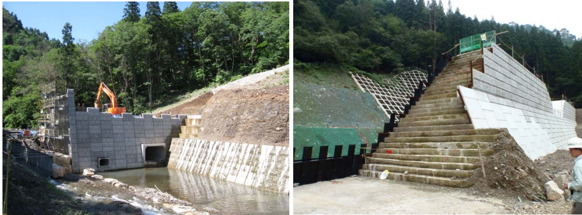
写真- 4.23 半川施工事例（左：隔壁設置例・右：スロープ状施工事例）
