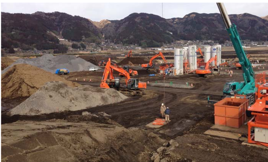
写真- 4.14 複数台の INSEM プラントを活用し、INSEM 集中プラントの例
