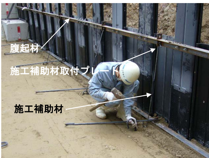
写真- 4.52 施工補助材の設置
