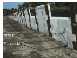
アンカー材設置
