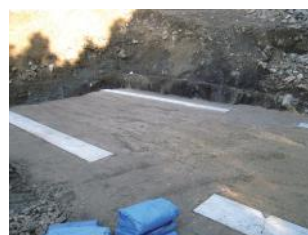
基礎均しコンクリート打設
