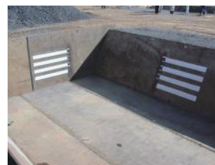
混合施設設置
