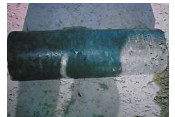
内部材コア抜き写真
