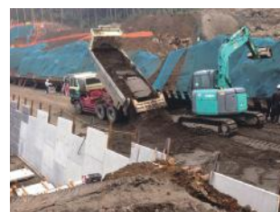
INSEM材の投入・敷き均し
