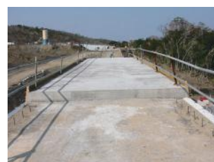
天端保護コンクリート打設
