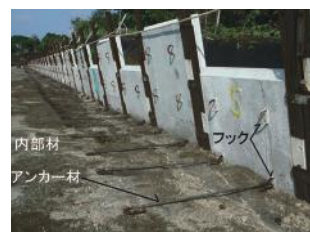
アンカー材設置
