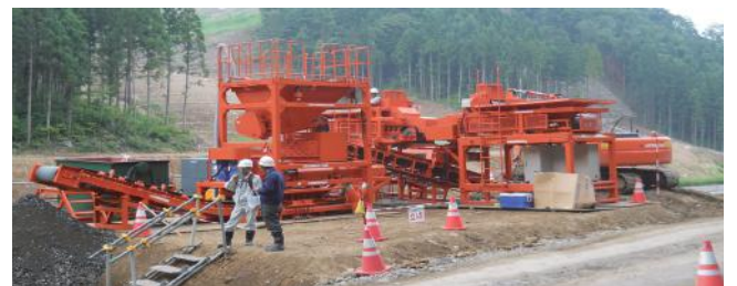
SB ウォール工法の機械化施工(INSEM 専用製造プラント)
