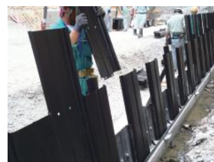
外部保護材組立（上流部）
