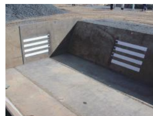
混合施設設置
