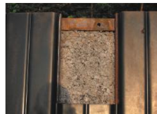
壁面内部材確認状況
