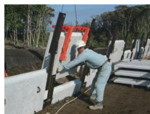
外部保護材組立（下流部）
