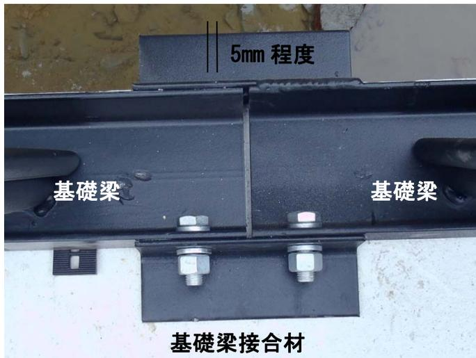
写真- 4.31 基礎梁の設置
