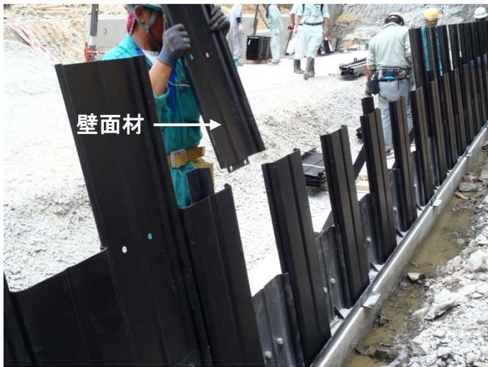
写真- 4.40 壁面材の建て込み
