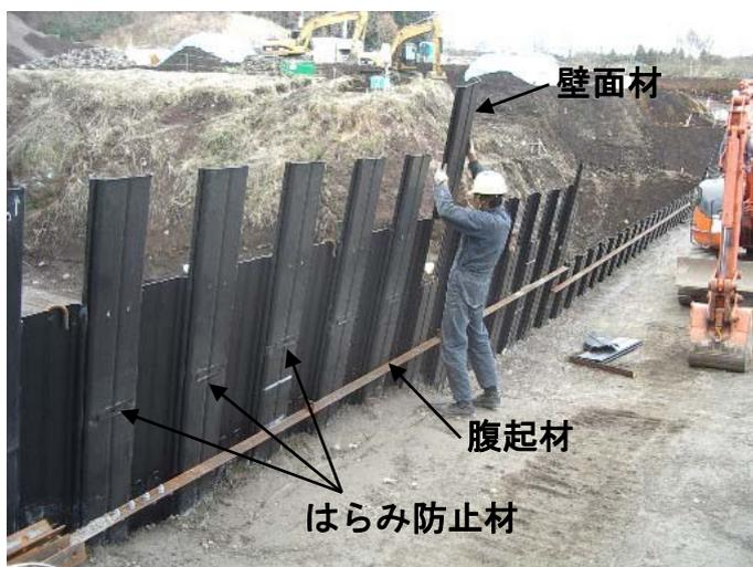
写真- 4.45 壁面材の建て込み
