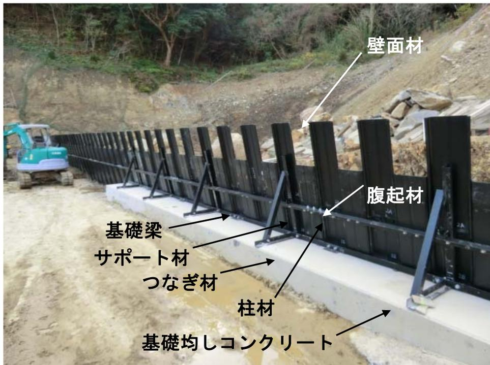
写真- 4.27 基礎部外部保護材の部材名称
