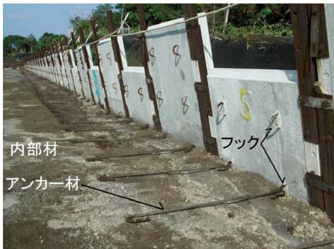
写真- 4.60 アンカー材の設置
