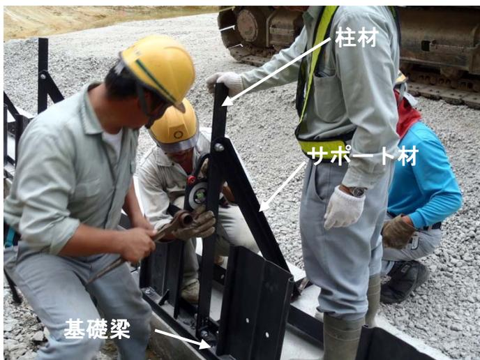
写真- 4.39 柱材・サポート材の組立
