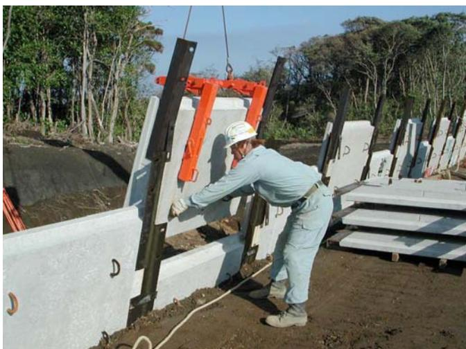
写真- 4.64 外部保護材の設置
