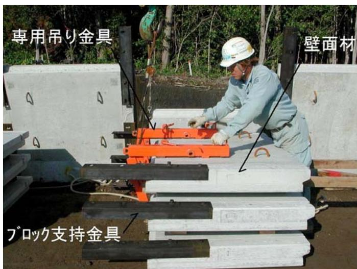
写真- 4.62 専用吊り金具の取付
