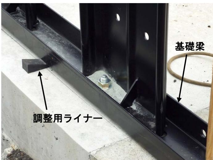
写真- 4.36 基礎梁の高さ調整
