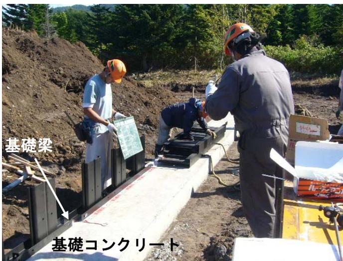
写真- 4.29 基礎梁の設置
