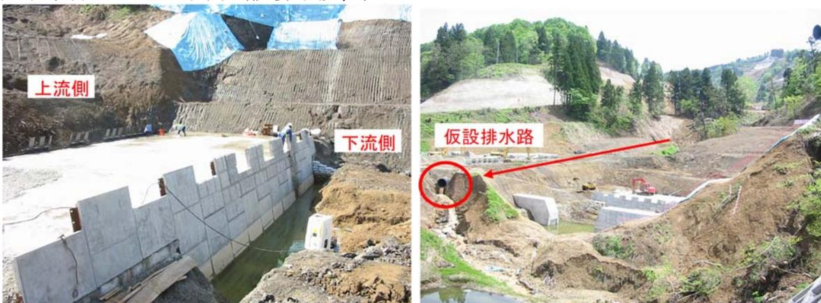
写真- 4.20 左：正面方向状況・右：仮排水設置状況
