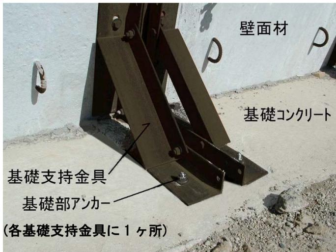
写真- 4.59 基礎支持金具の固定
