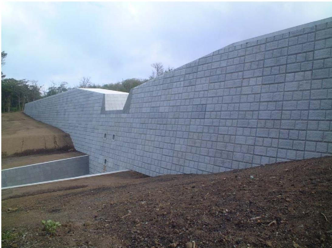
写真- 4.70 下流外部保護材（コンクリートブロック）
