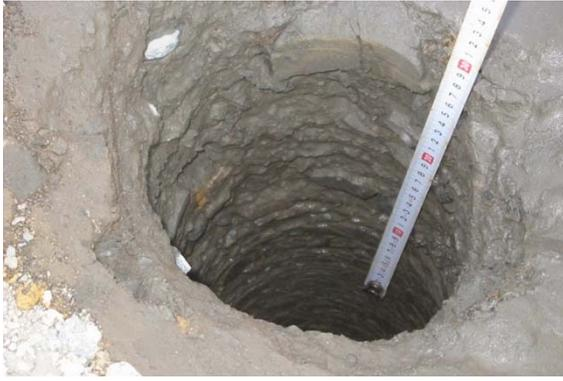
写真- 3.4 コア抜き後内部材状況
