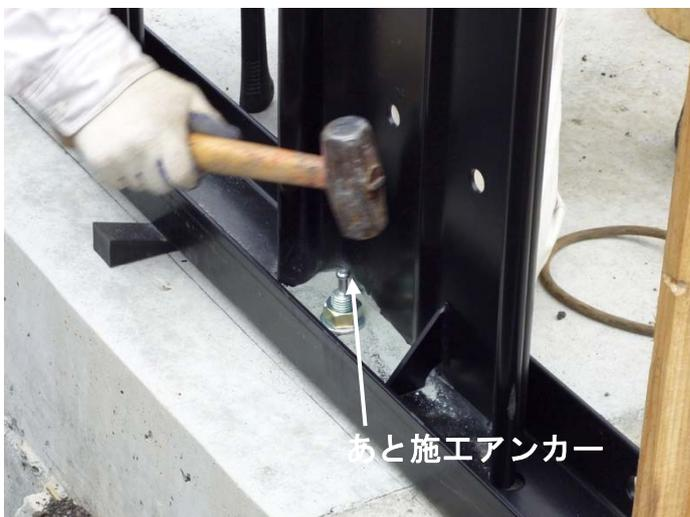
写真- 4.35 あと施工アンカーの打込み
