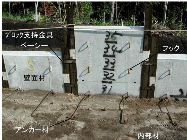
写真- 4.61 外部保護材のり面部の部材名称
