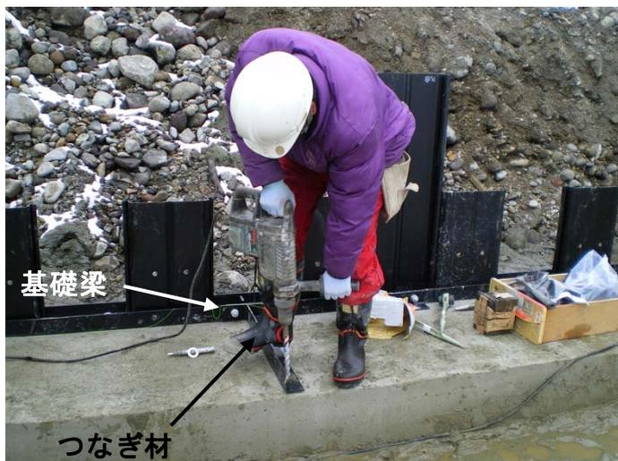
写真- 4.34 あと施工アンカー位置の削孔
