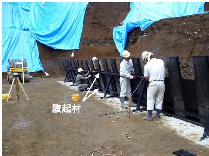
写真- 4.42 腹起材の設置
