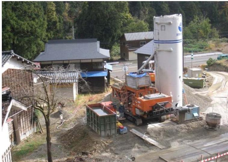
写真-4.5 土砂ストック，混合ヤードの配置例：モデル3 事例
