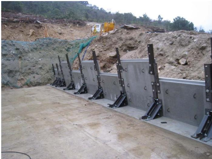
写真- 4.58 外部保護材の調整
