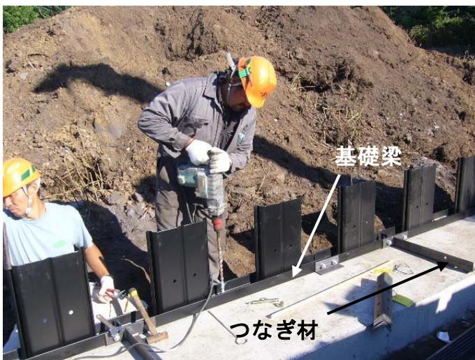
写真- 4.33 あと施工アンカー位置の削孔
