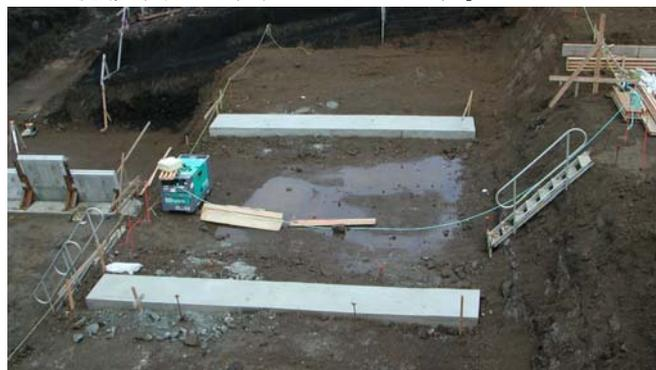
写真-4.26 基礎均しコンクリートの打設例
