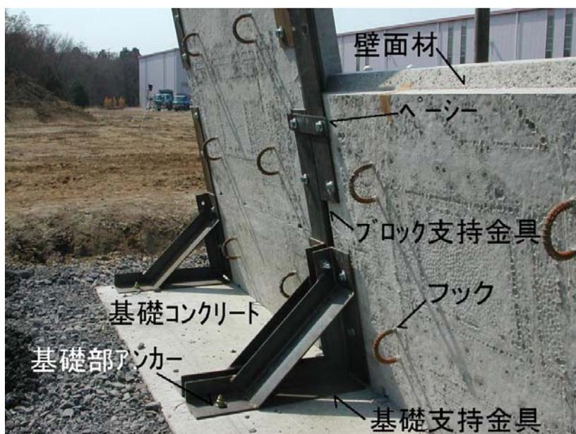
写真- 4.51 基礎部外部保護材の部材名称
