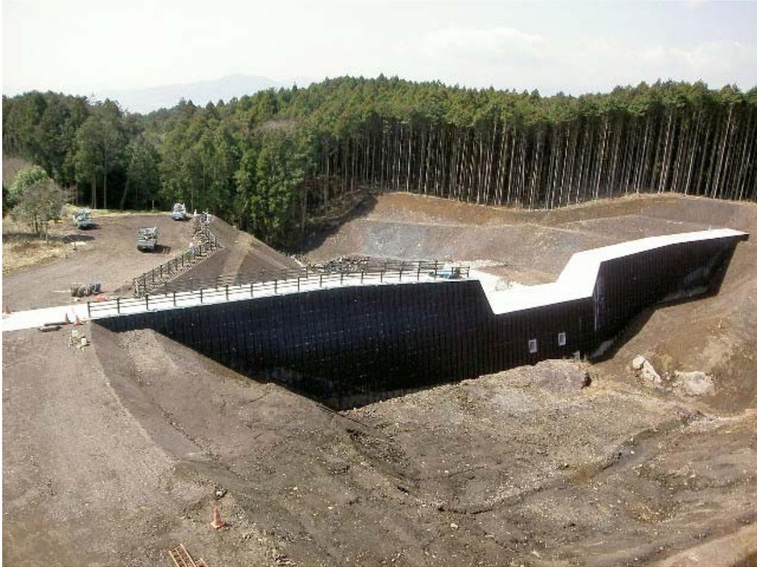
写真- 4.69 上流外部保護材（軽量鋼矢板）
