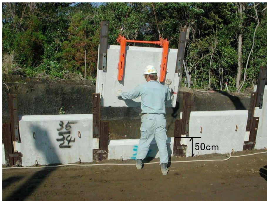
写真-4.24 外部保護材の組立状況
