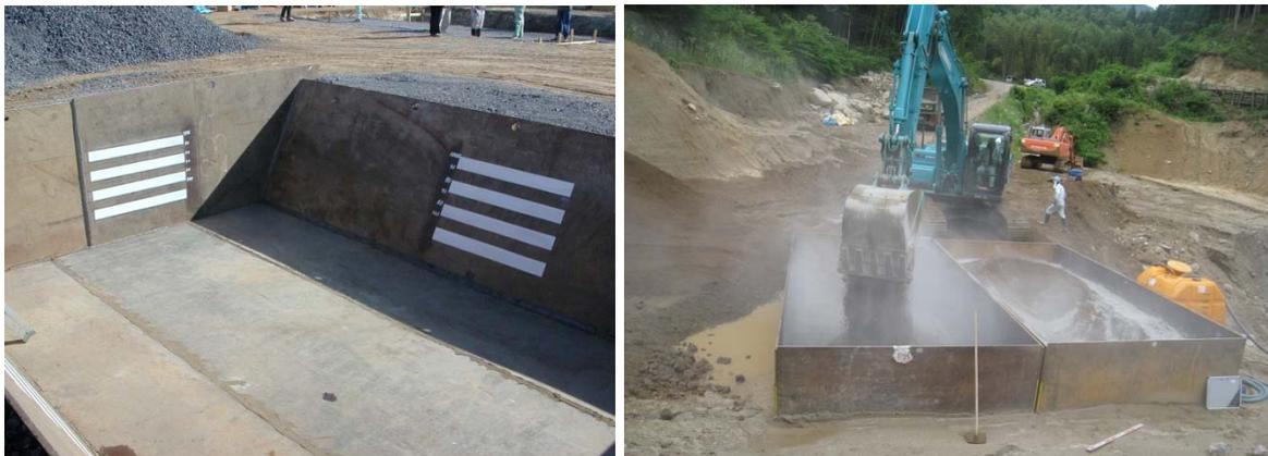
写真- 4.4 混合樹の製作例 (左 : 単設混合樹, 右 : 複設混合樹)
