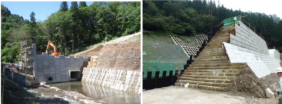
写真- 4.19 半川施工事例（左：隔壁設置例・右：スロープ状施工事例）
