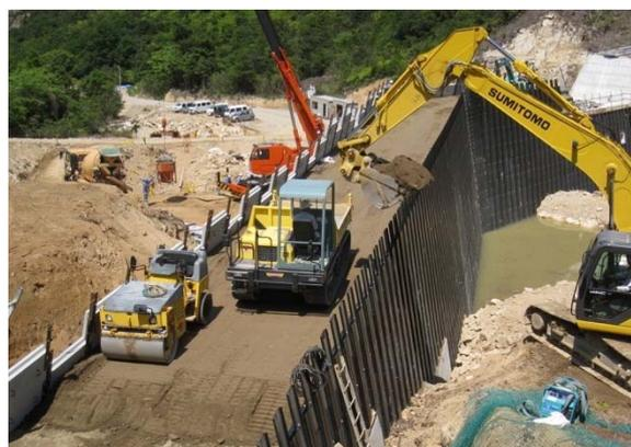
写真- 4.13 内部材の運搬状況（バックホウによる直接投入）
