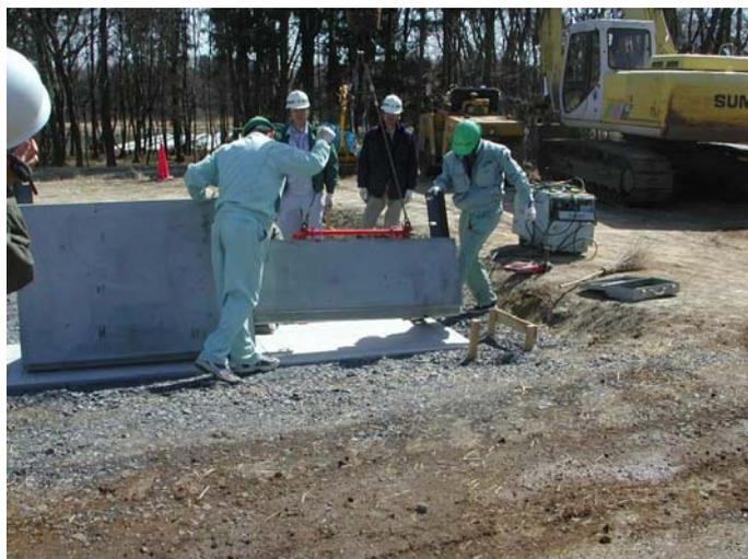
写真- 4.57 1 段目外部保護材の設置
