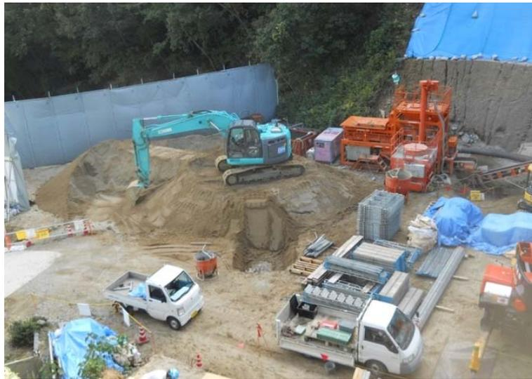
写真-4.4 土砂ストック，混合ヤードの配置例：モデル1 事例
