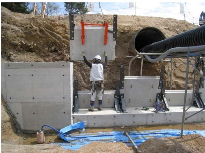
写真- 4.63 外部保護材の設置
