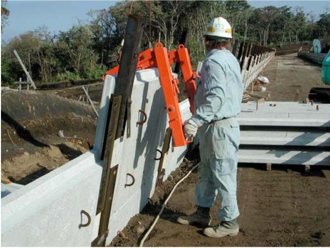
写真- 4.66 専用吊り金具の取り外し
