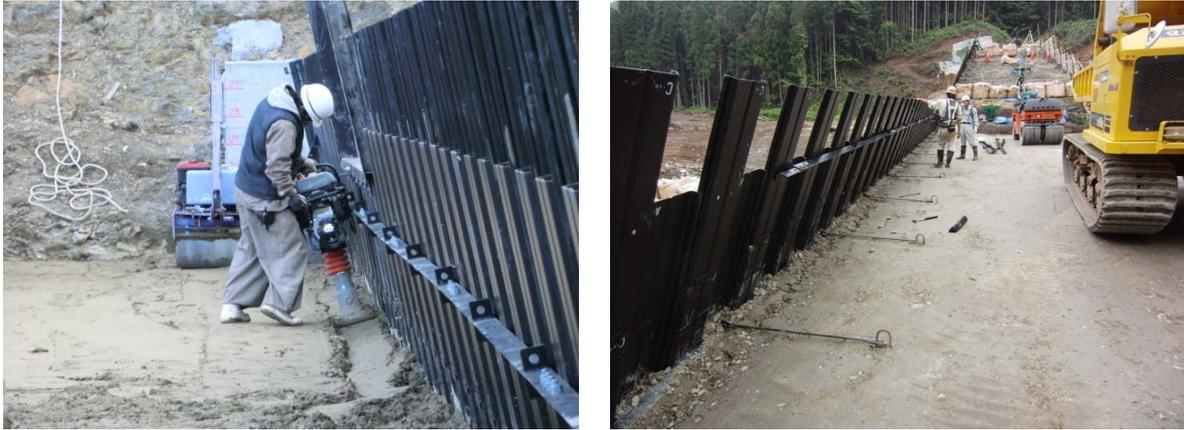
写真- 4.16 左：ランマによる締固め・右：外部保護材近傍の内部材
