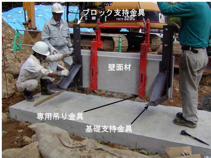
写真- 4.56 1 段目外部保護材の設置
