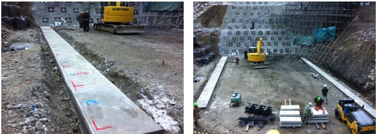
写真- 3.1 基礎均しコンクリート設置状況
