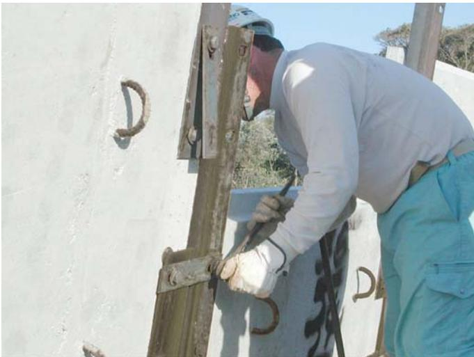
写真- 4.67 外部保護材ののり面勾配調整
