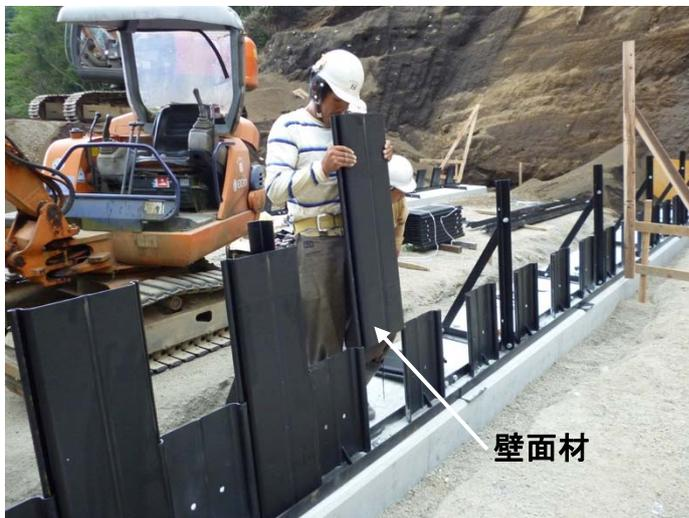
写真- 4.41 壁面材の建て込み
