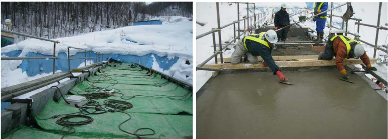
写真- 4.21 天端保護コンクリート施工実施事例
