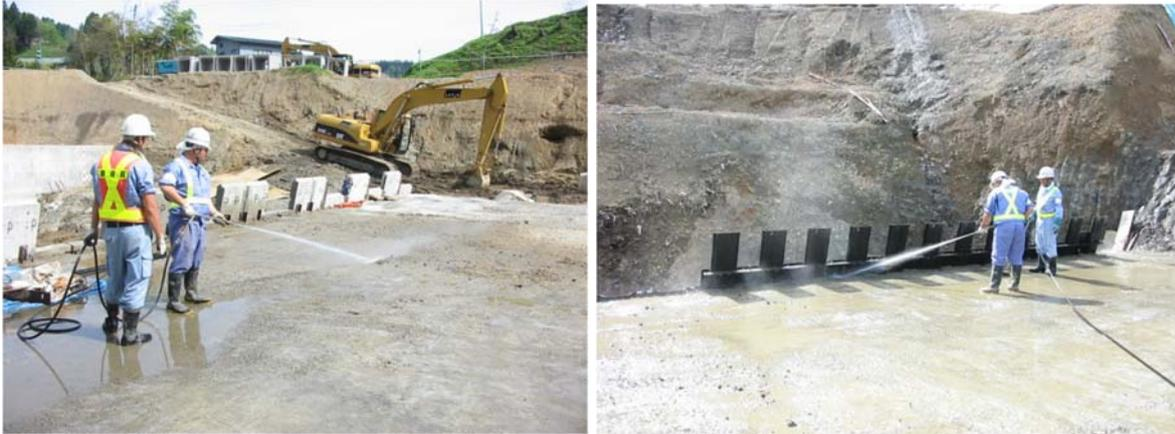
写真- 4.17 右：中央部清掃・水散布状況・左：端部清掃・水散布状況
