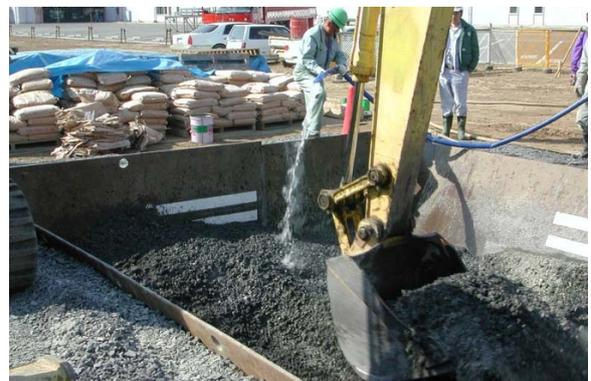
写真- 4.8 混合機への加水状況
