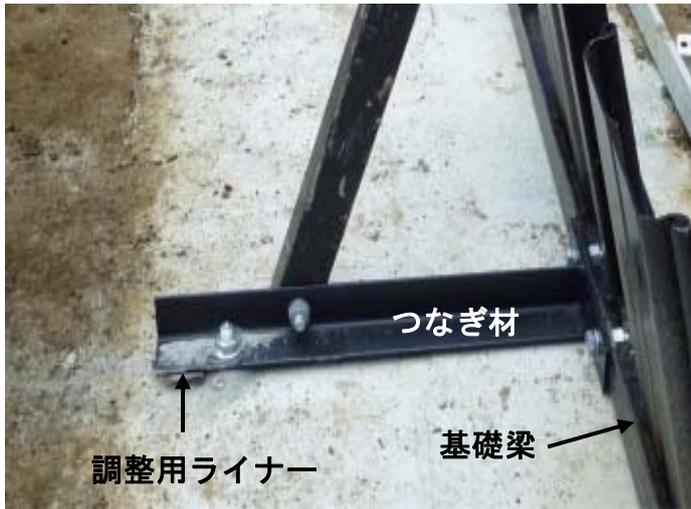
写真- 4.37 つなぎ材の高さ調整
