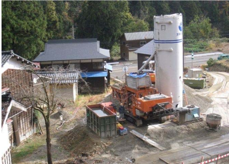
写真-4.5 土砂ストック，混合ヤードの配置例：モデル3事例 (INSEM プラント→内部材製造，ダンプトラック運搬)
