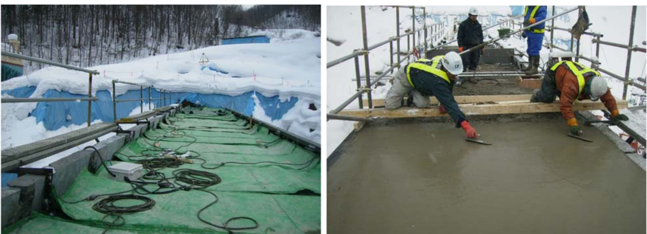
写真-4.25 天端保護コンクリート施工実施事例
