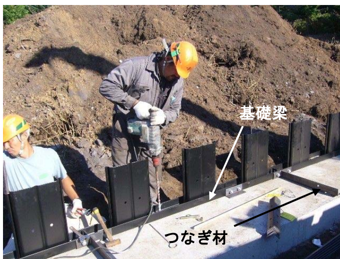
写真- 4.37 あと施工アンカー位置の削孔
