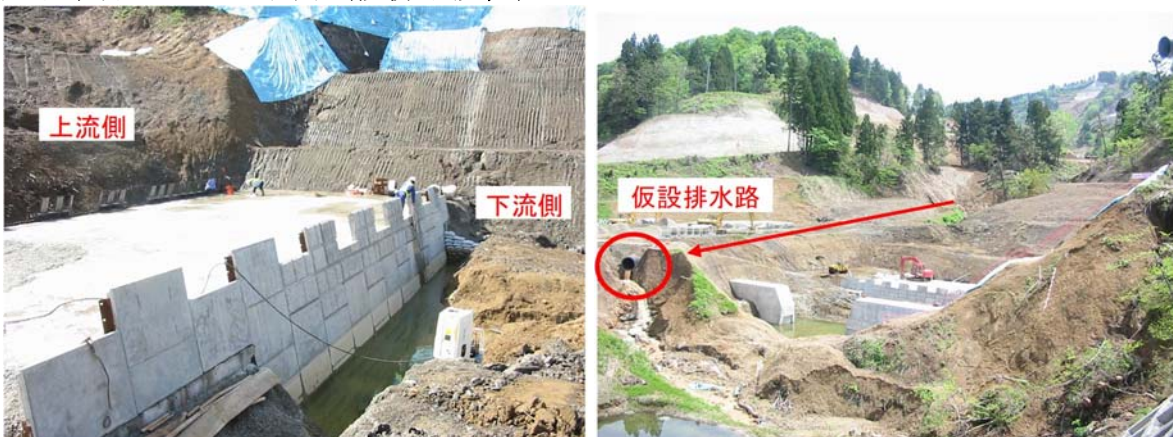
写真- 4.24 左：正面方向状況・右：仮排水設置状況
