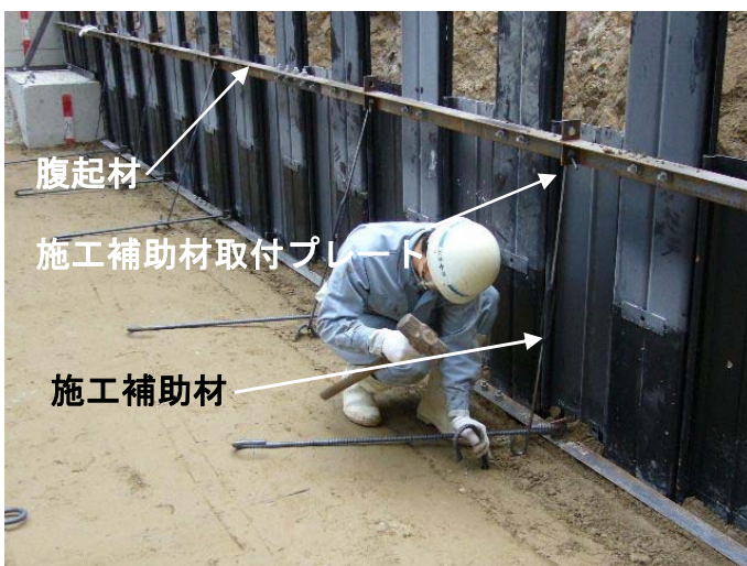
写真- 4.52 施工補助材の設置
