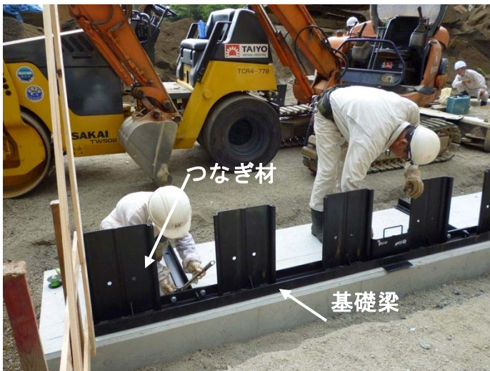
写真- 4.36 つなぎ材の設置
