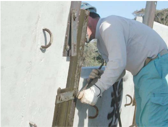
写真- 4.71 外部保護材ののり面勾配調整
