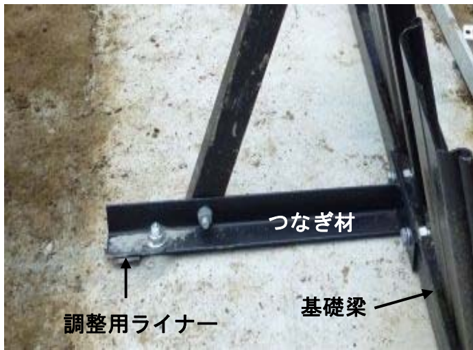
写真- 4.41 つなぎ材の高さ調整
