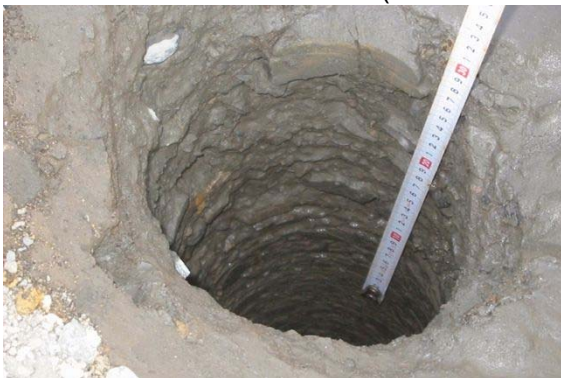
写真- 3.4 コア抜き後内部材状況
