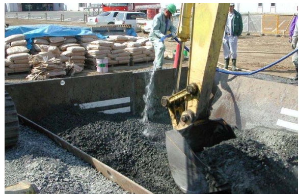
写真- 4.12 混合枡への加水状況
