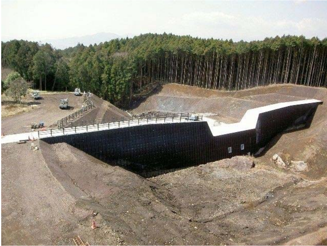
写真- 4.73 上流外部保護材（軽量鋼矢板）
