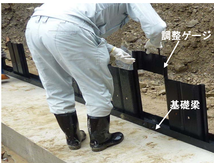
写真- 4.34 基礎梁の設置
