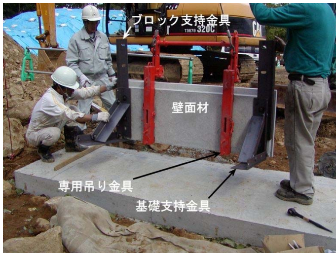
写真- 4.60 1 段目外部保護材の設置
