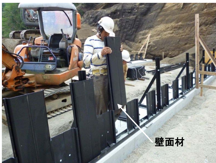
写真- 4.45 壁面材の建て込み
