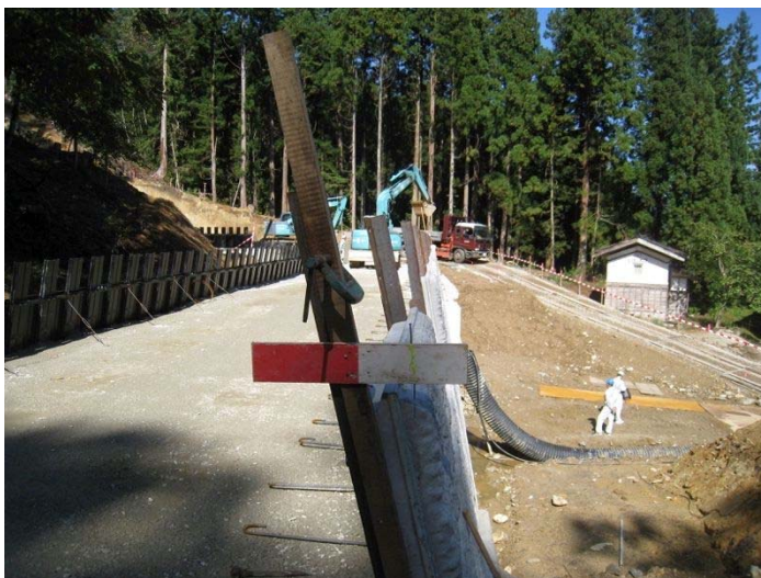
写真- 4.72 外部保護材ののり面勾配丁張り
