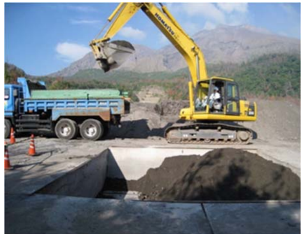
写真- 4.15 内部材の積込み状況
