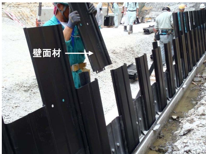
写真- 4.44 壁面材の建て込み
