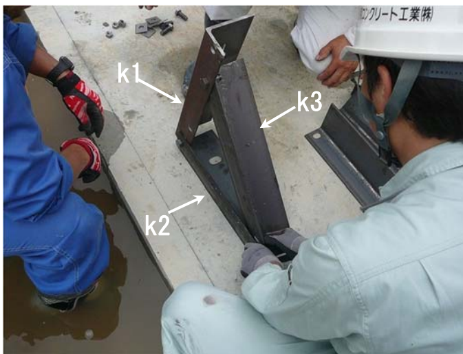
写真- 4.57 基礎支持金具の組立
