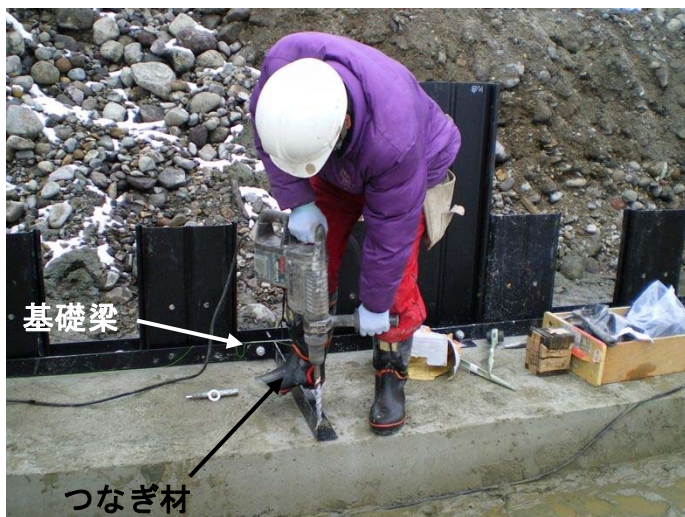
写真- 4.38 あと施工アンカー位置の削孔
