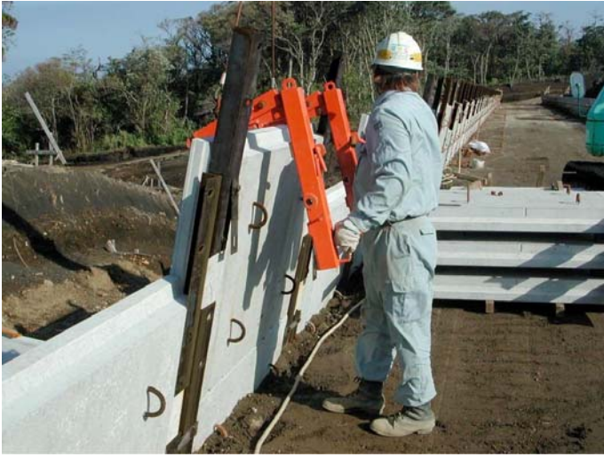
写真- 4.70 専用吊り金具の取り外し
