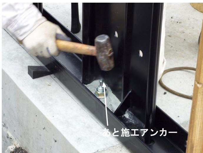
写真- 4.39 あと施工アンカーの打込み
