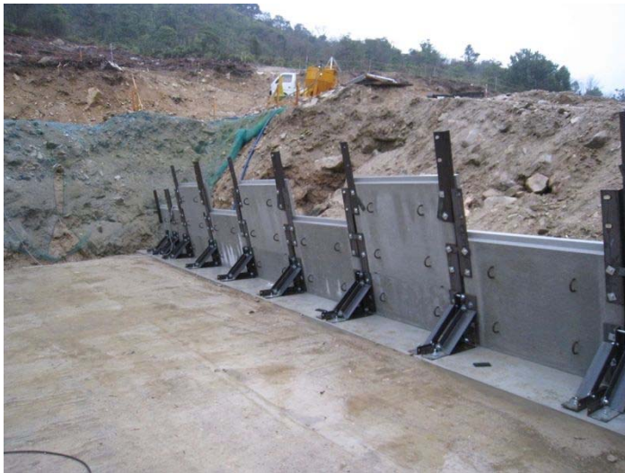
写真- 4.62 外部保護材の調整
