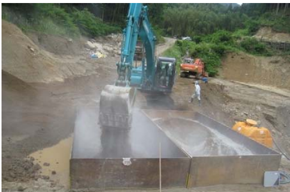
写真- 4.12 混合枡への加水状況
