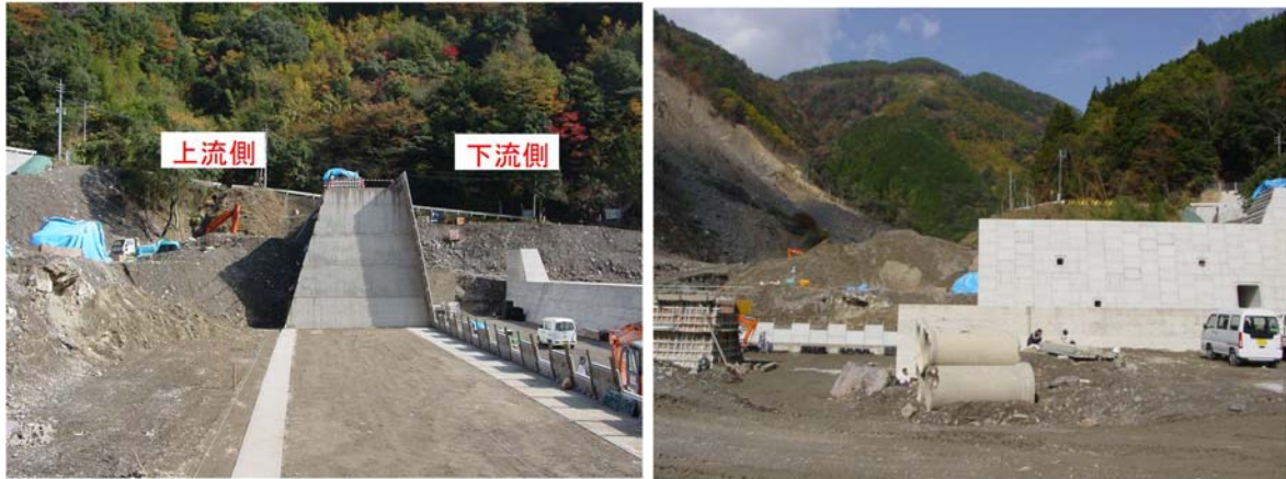
写真- 4.22 左：ダム軸方向状況・右：正面方向状況
