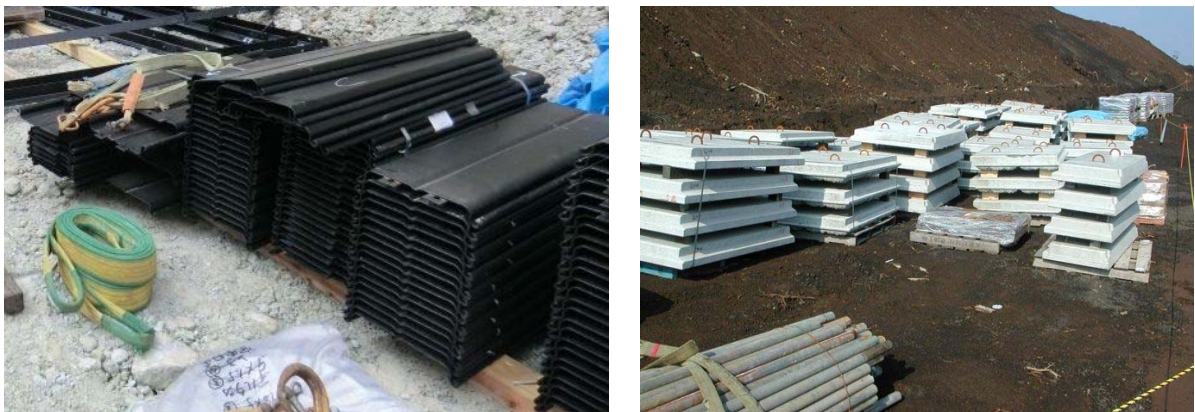
写真- 4.29 左：鋼材の梱包状態 右：コンクリートブロックの梱包状態 15,000
