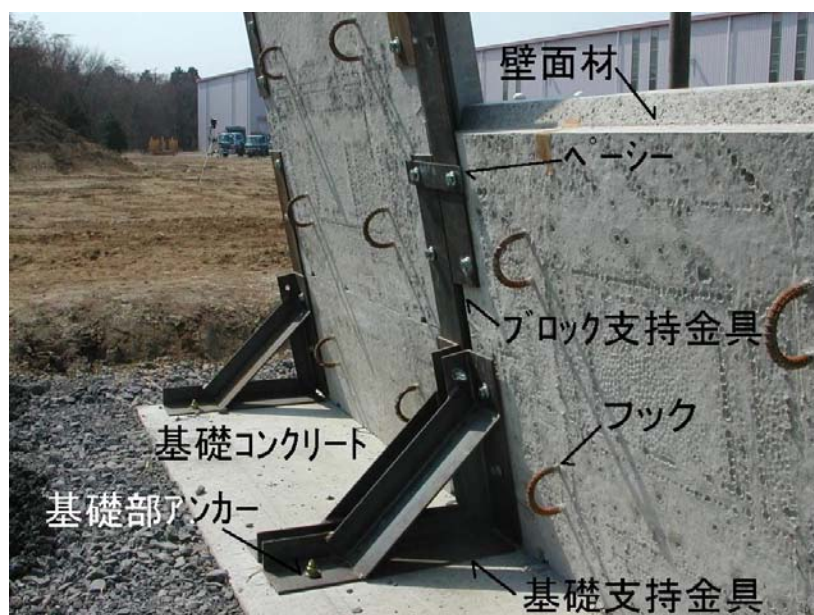
写真- 4.55 基礎部外部保護材の部材名称
