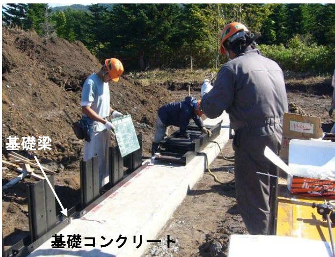
写真- 4.33 基礎梁の設置
