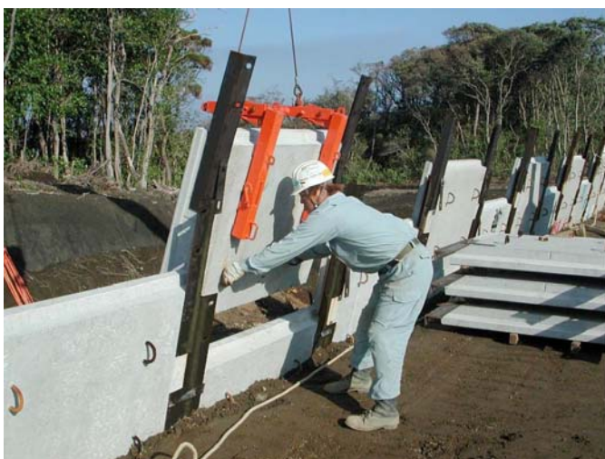
写真- 4.68 外部保護材の設置
