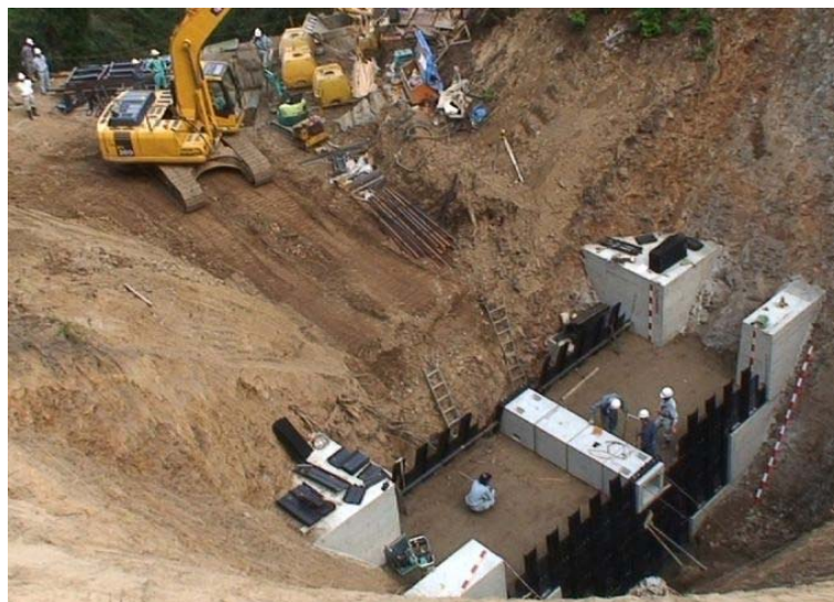
写真- 4.3 土砂ストック，混合ヤードの配置例：モデル2事例 (バックホウ混合→内部材製造，バックホウによる直接投入)
