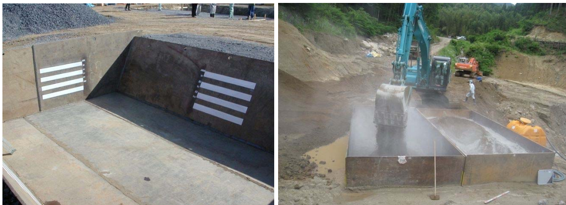
写真- 4.8 混合樹の製作例 (左 : 単設混合樹, 右 : 複設混合樹)
