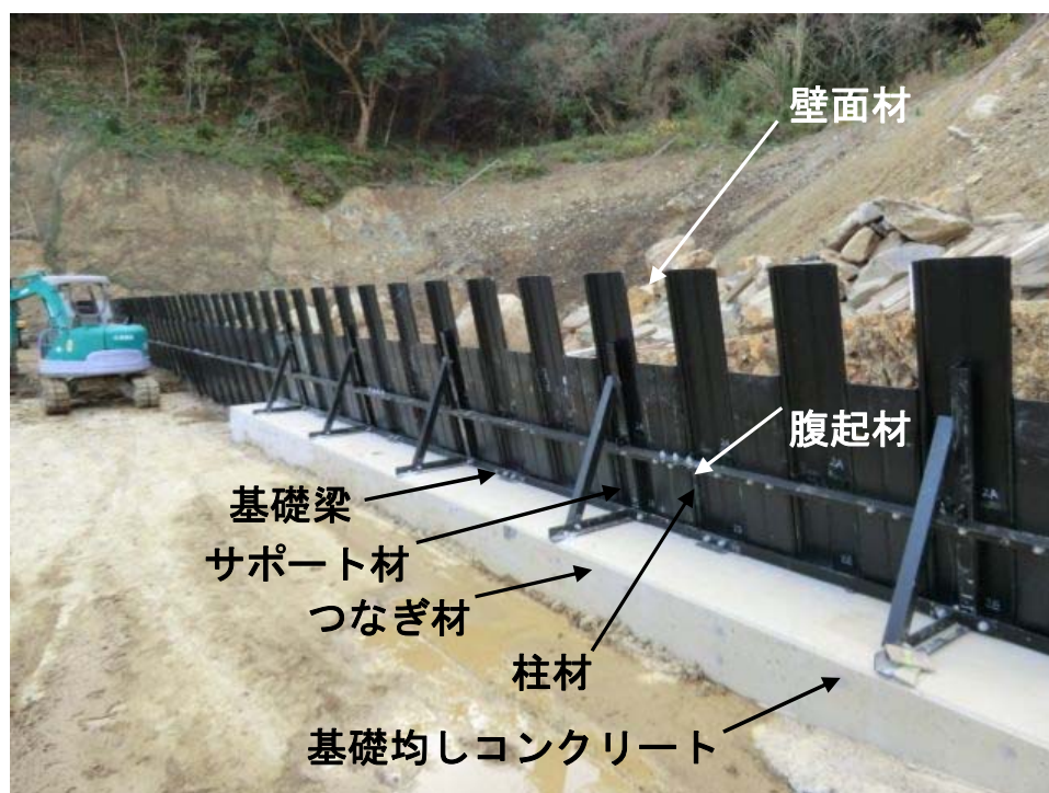
写真- 4.31 基礎部外部保護材の部材名称
