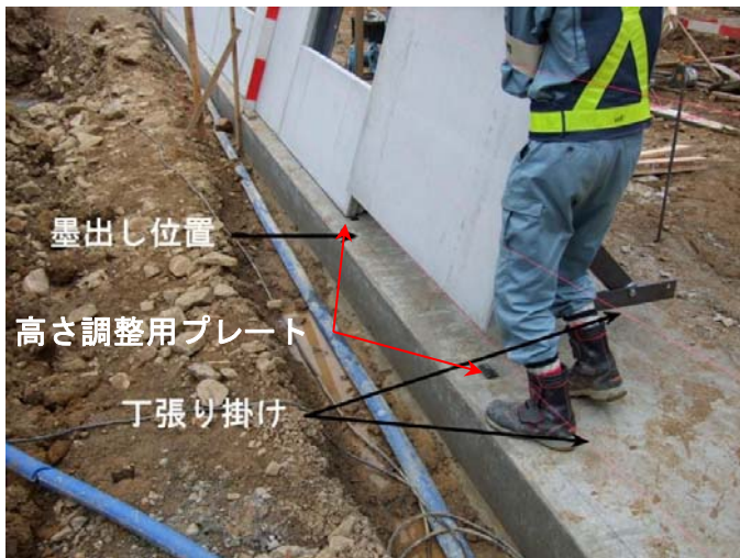
写真- 4.56 基礎部 墨出し・丁張り掛け
