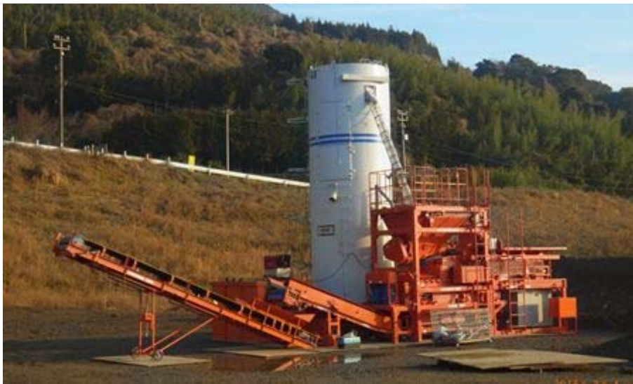
写真- 4.13 セメントサイロを接続した INSEM プラントの例
