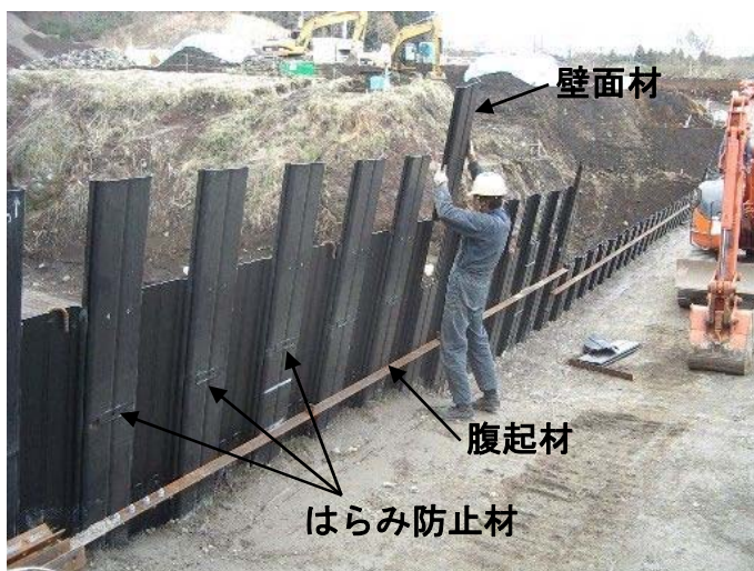
写真- 4.49 壁面材の建て込み
