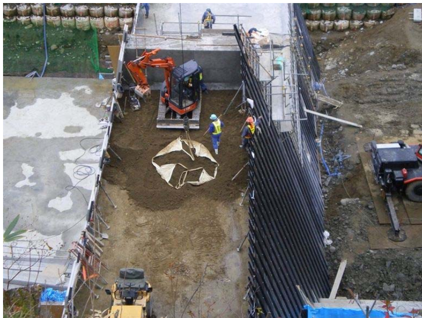
写真-4.18 バックホウによる内部材の敷均し
