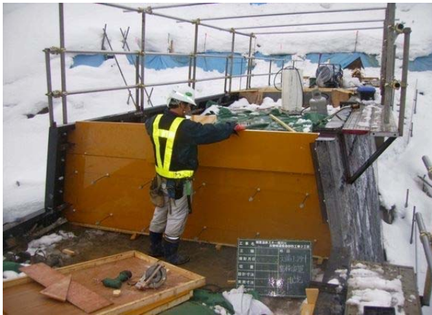
写真- 4.26 水通しコンクリート施工実施事例
