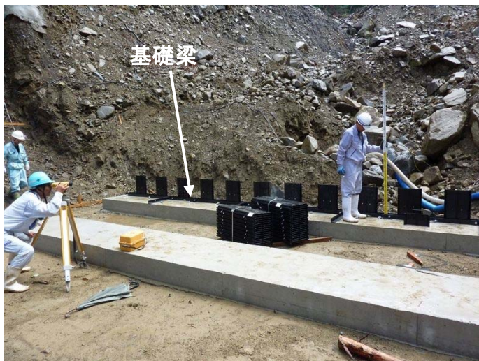
写真- 4.42 基礎梁・つなぎ材の高さ調整
