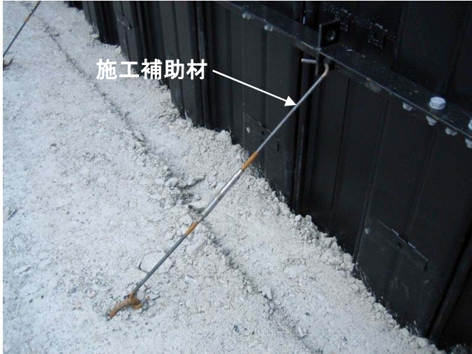
写真- 4.53 施工補助材の設置
