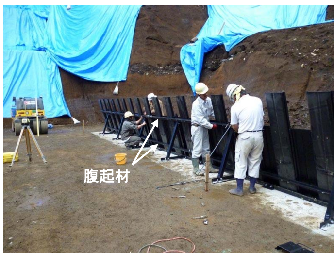
写真- 4.46 腹起材の設置
