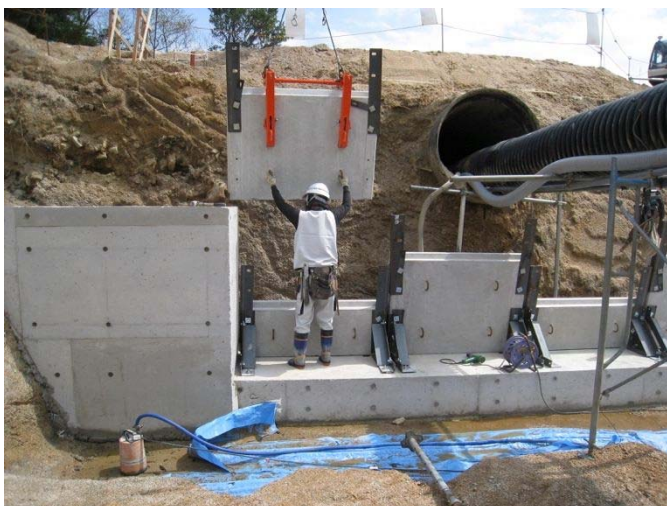
写真- 4.67 外部保護材の設置
