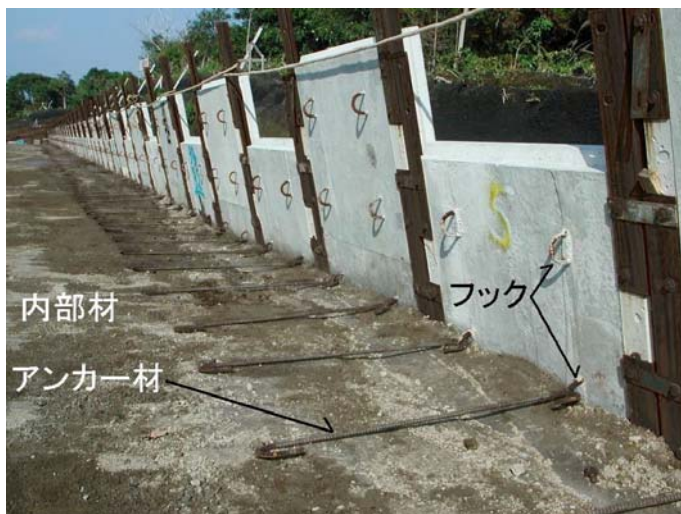
写真- 4.64 アンカー材の設置
