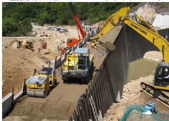
写真- 4.17 内部材の運搬状況（バックホウによる直接投入）
