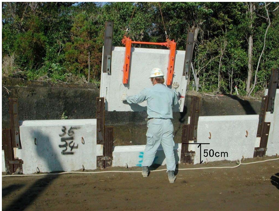
写真-4.28 外部保護材の組立状況
