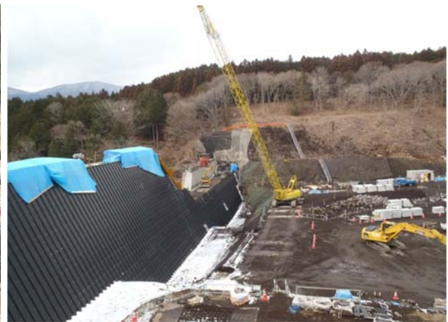
写真- 4.16 内部材の運搬状況（左：ダンプトラック、右：ラフテレーンクレーン）
