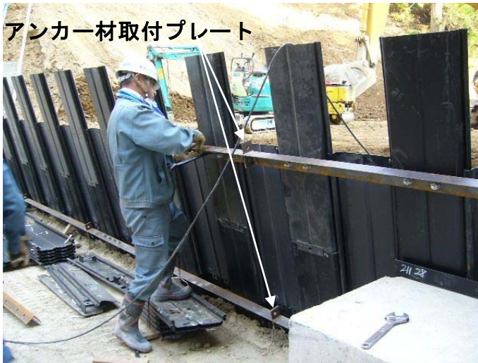
写真- 4.50 腹起材の設置
