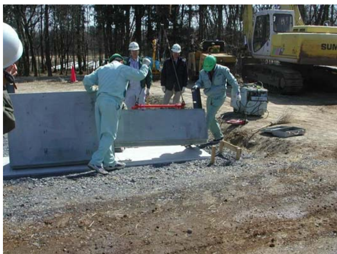
写真- 4.61 1 段目外部保護材の設置
