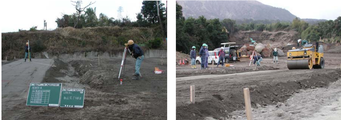
写真- 4.1 試験施工の状況
