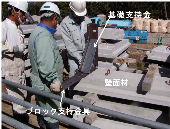
写真- 4.59 基礎支持金具の取付
