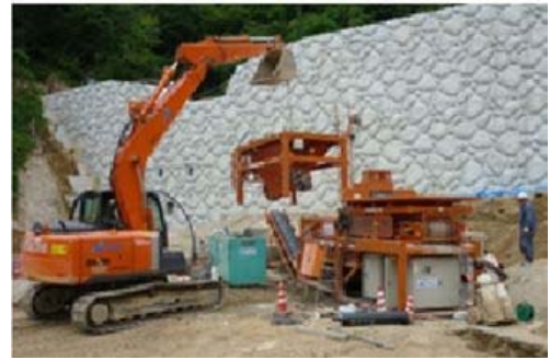
写真-4.7 INSEM プラントの組立状
