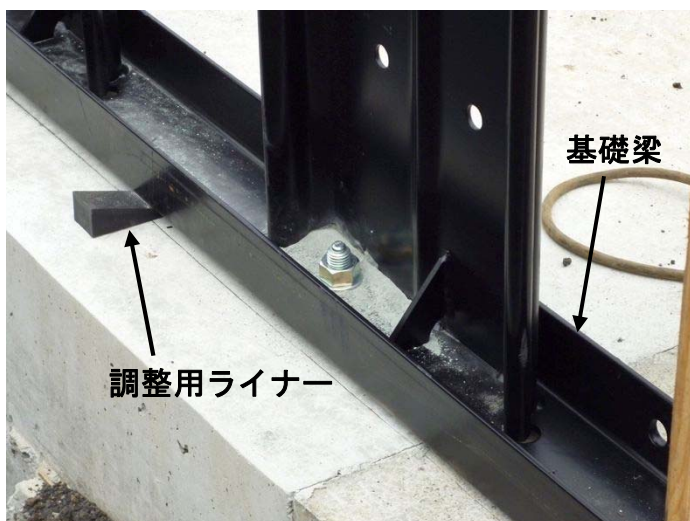
写真- 4.40 基礎梁の高さ調整
