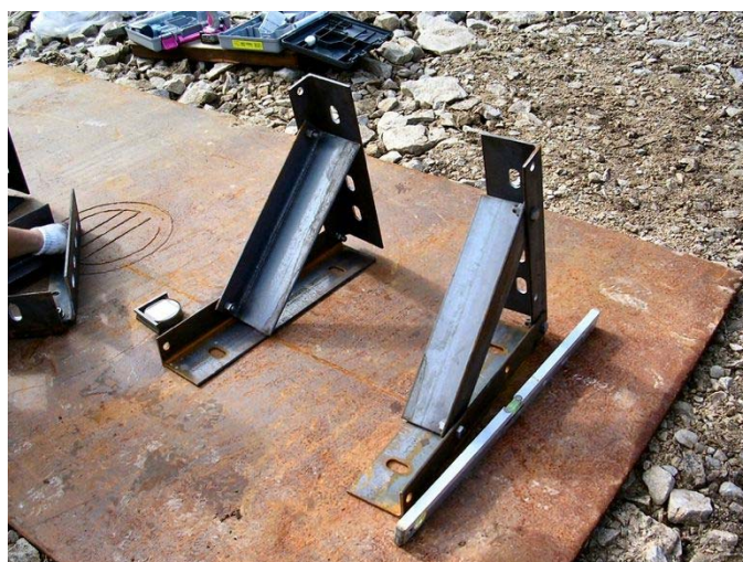
写真- 4.58 基礎支持金具の組立
