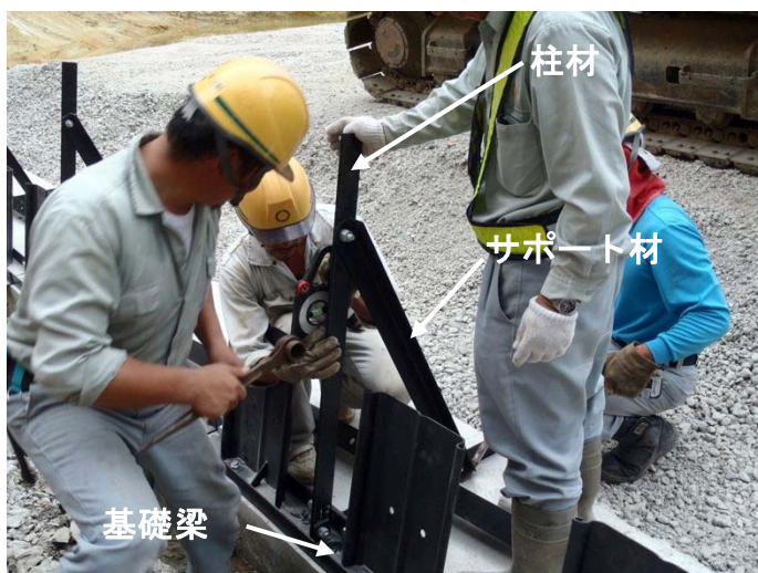
写真- 4.43 柱材・サポート材の組立
